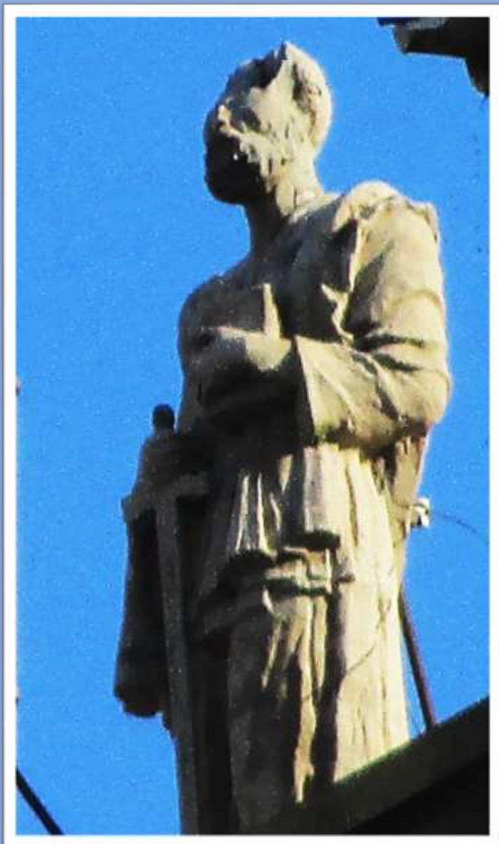
Così appariva la testa della statua danneggiata da un fulmine
