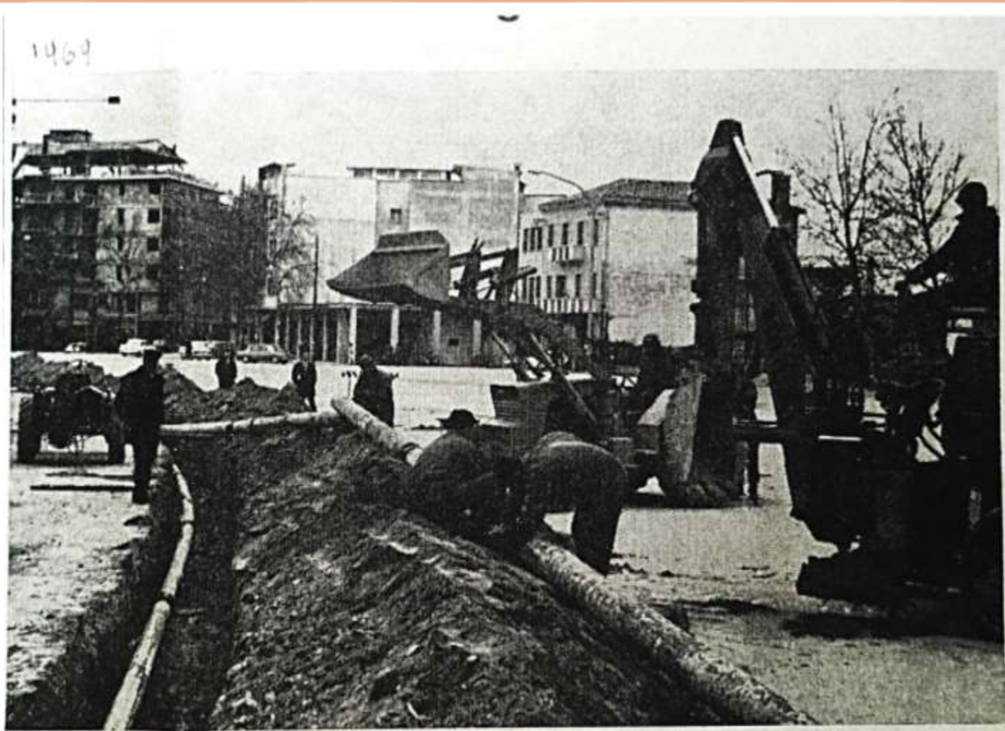
Prosegue celermente la costruzione della rete di erogazione del gas. Nella foto (Milanese), lo scavo e la posa dei tubi in Piazza Indipendenza. 4 NOVEMBRE
