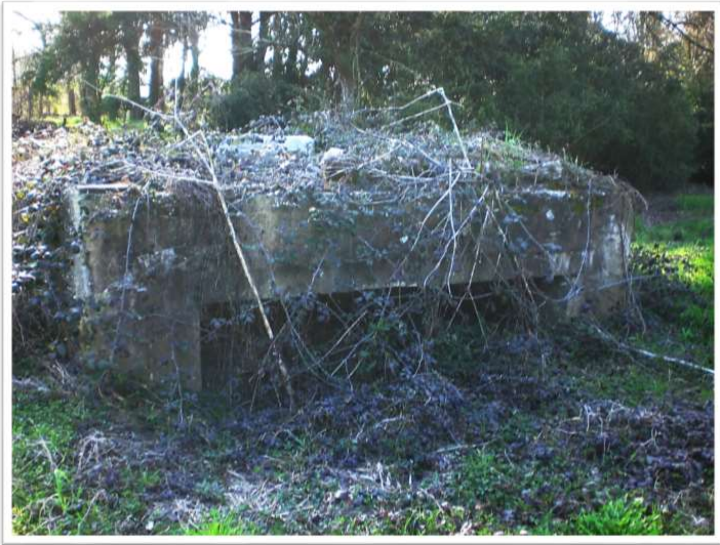
Rifugio sotterraneo in cemento armato dove la famiglia si rifugiava dai bombardamenti
