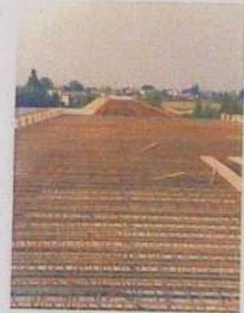
Agosto 1990: Lavori di ricostruzione del ponte. (foto di Mario Panasi).
