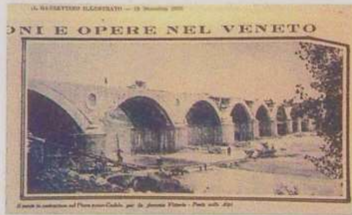
Il ponte in costruzione sul Piave presso Cadola per la ferrovia Vittorio Veneto - Ponte nelle Alpi (13.12.1929)
