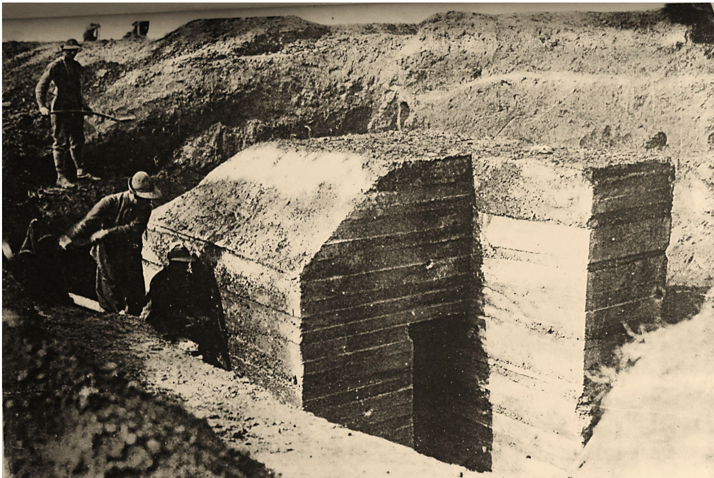
Archivio Fotografico club 54 una fortificazione in cemento armato all'interno dell'argine del fiume Piave
