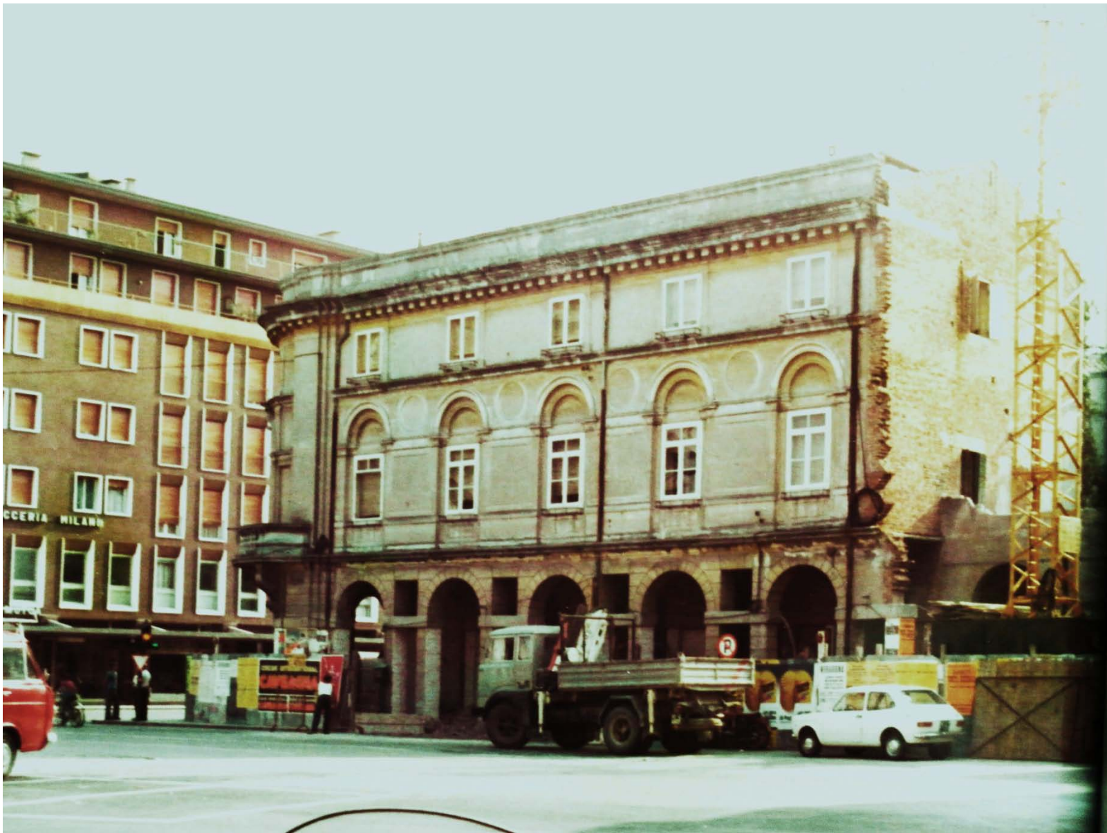
Archivio fotografico club 54 San Donà di Piave Piazza Trevisan inizio della ristrutturazione del palazzo Bressanin anno 1975
