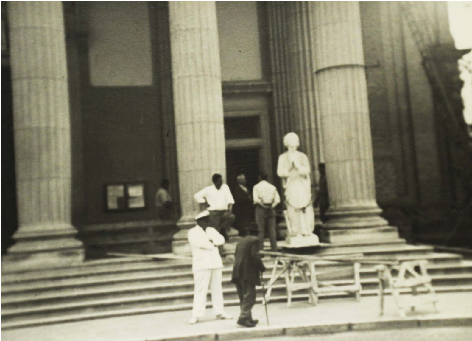
Archivio fotografico club 54 San Donà di Piave la statua è in posizione per essere issata e posizionata
