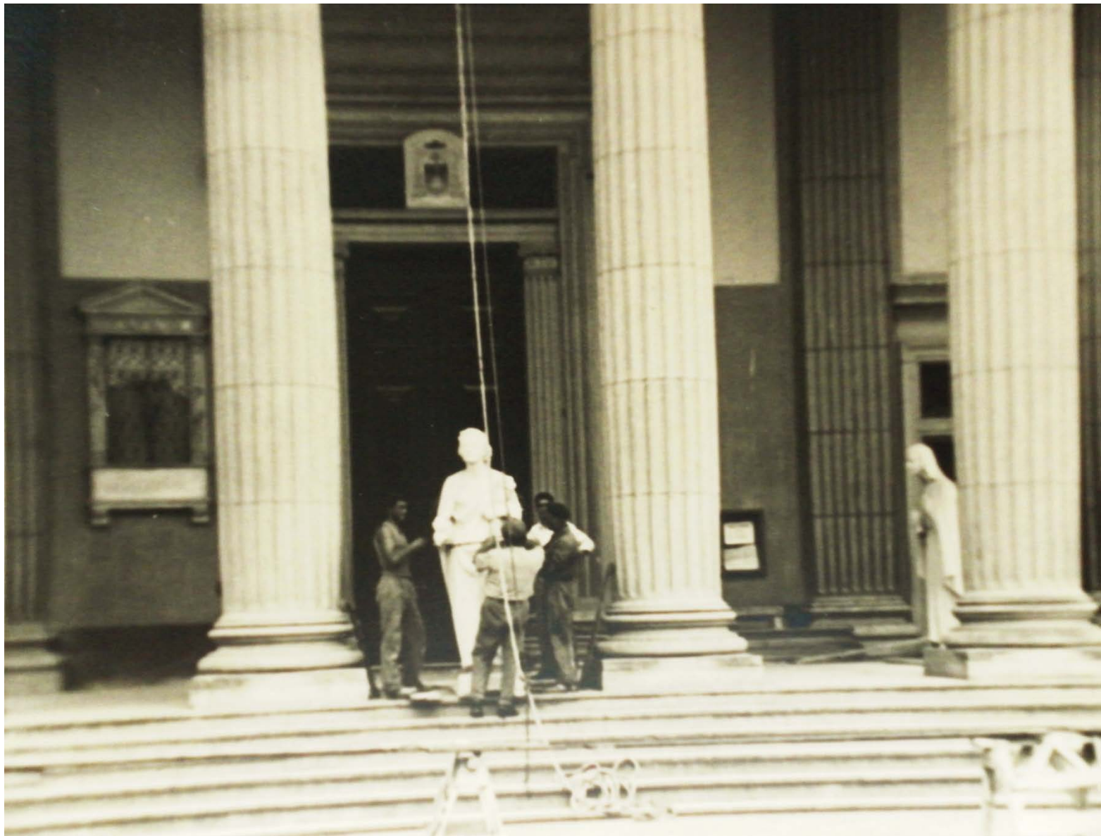
Archivio fotografico club 54 San Donà di Piave La seconda statua sta per essere posizionata sul basamento centrale
