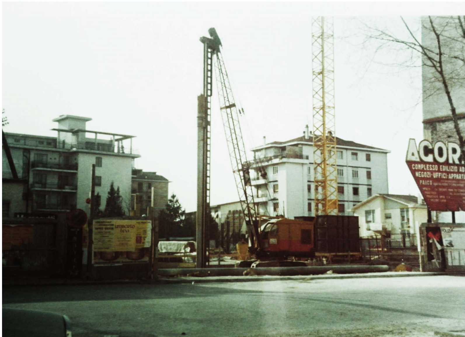
Archivio fotografico club 54 San Donà di Piave via Libertà inizio lavori del complesso AGORA'anno 1973
