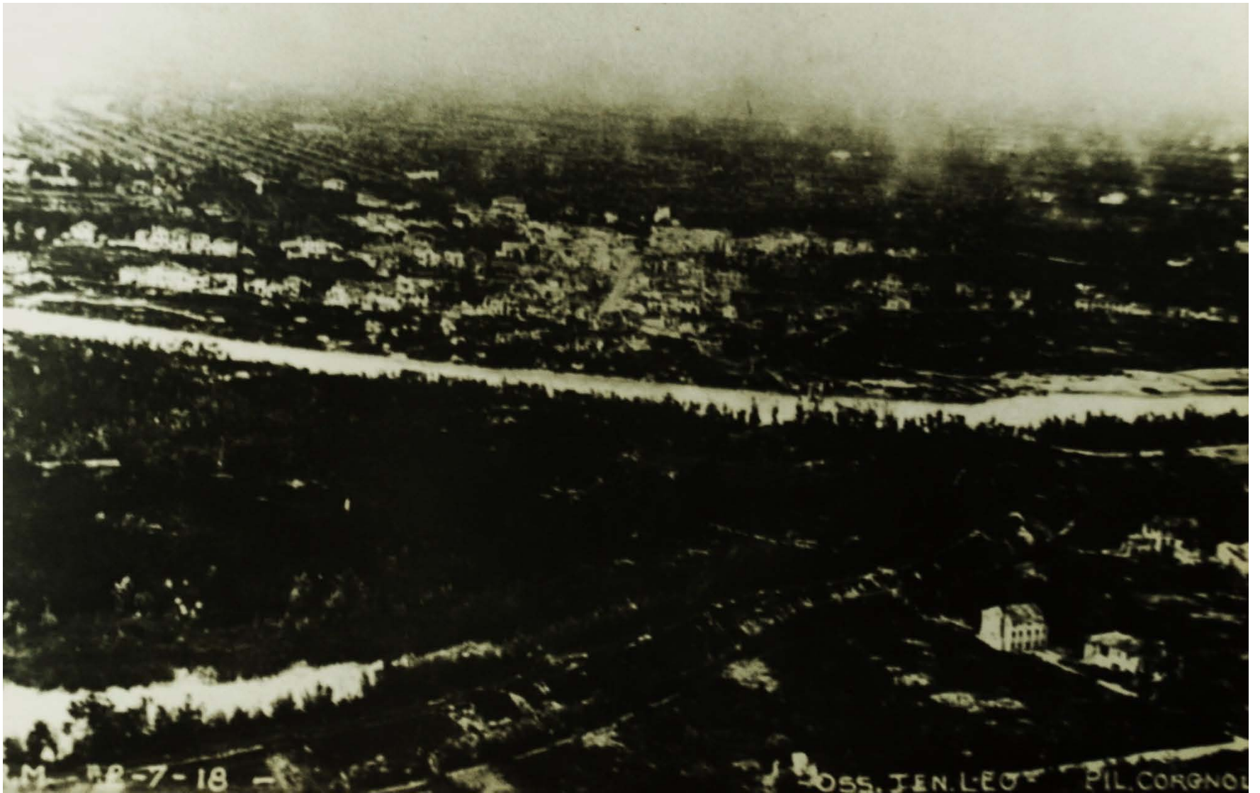
Archivio fotografico club 54 San Donà di Piave foto aerea del 8 luglio 1918 quello che rimaneva del centro dopo i continui bombardamenti.
