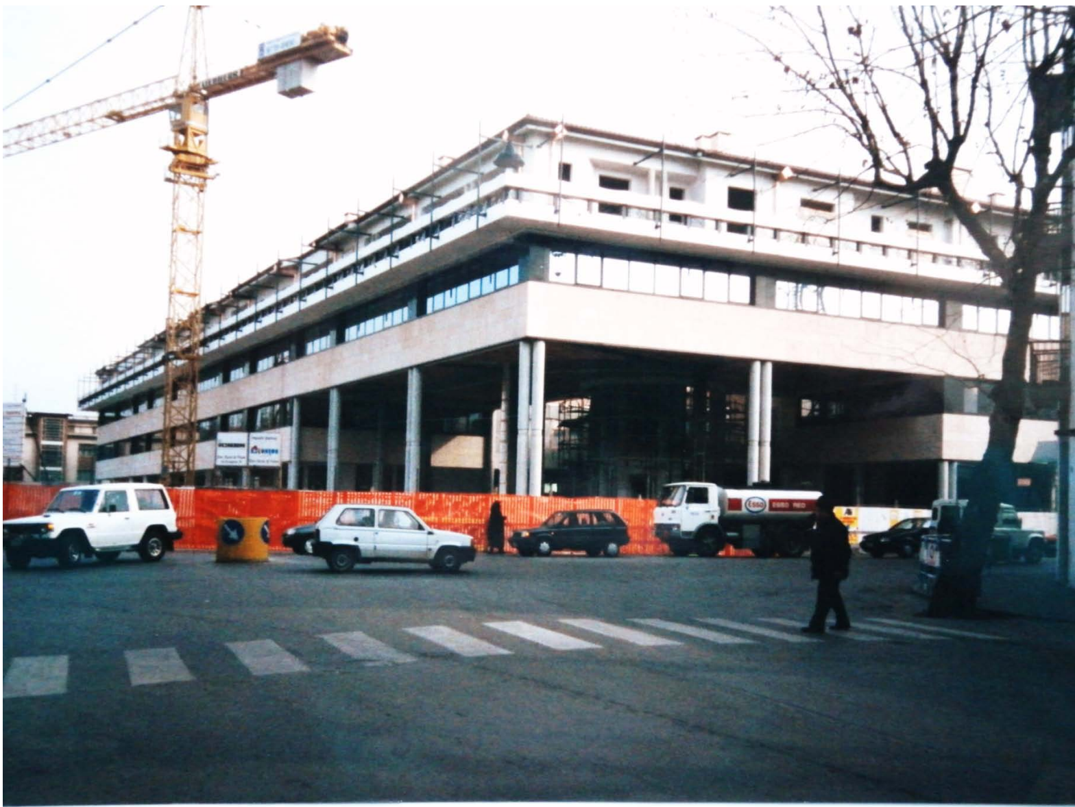
Archivio fotografico club 54 San Donà di Piave piazza 4 Novembre il complesso Europa in via di ultimazione
