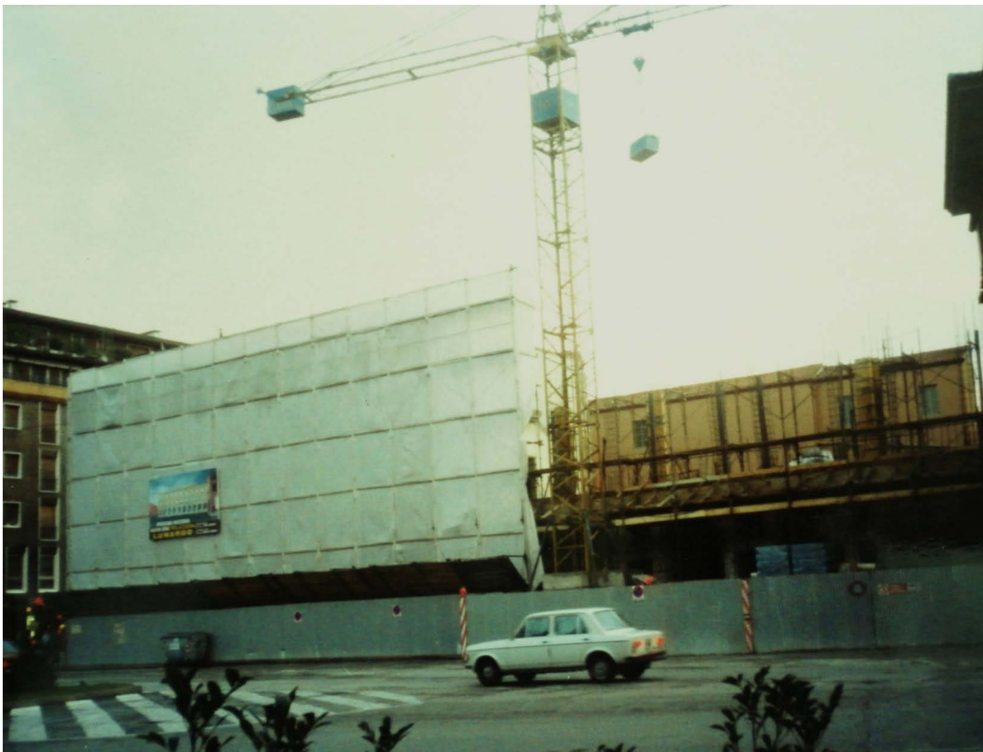
Archivio fotografico club 54 San Donà di Piave piazza Trevisan inizio del completamento del palazzo
