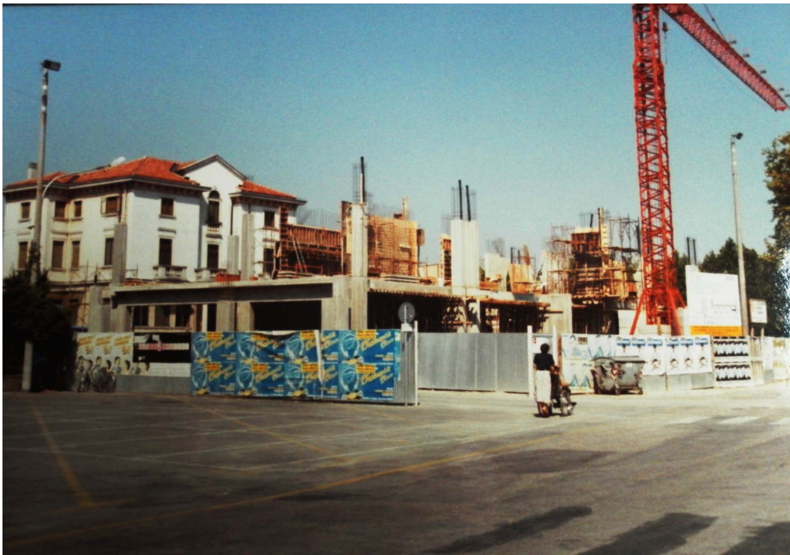
Archivio fotografico club 54 San Donà di Piave piazza 4 Novembre inizio lavori di costruzione della nuova autostazione anno 1987
