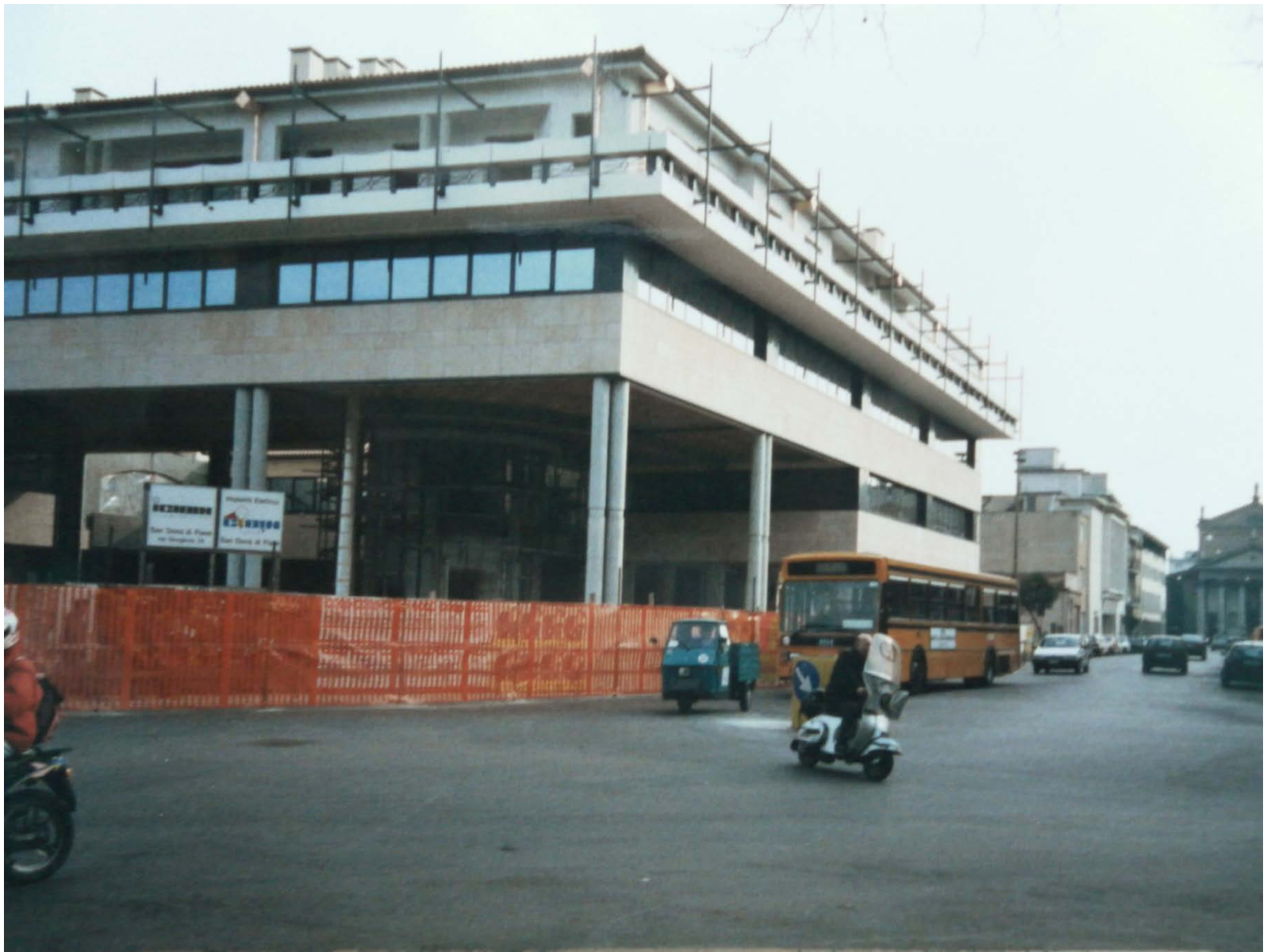
Archivio fotografico club 54 San Donà piazza 4 Novembre il complesso Europa in costruzione 1995
