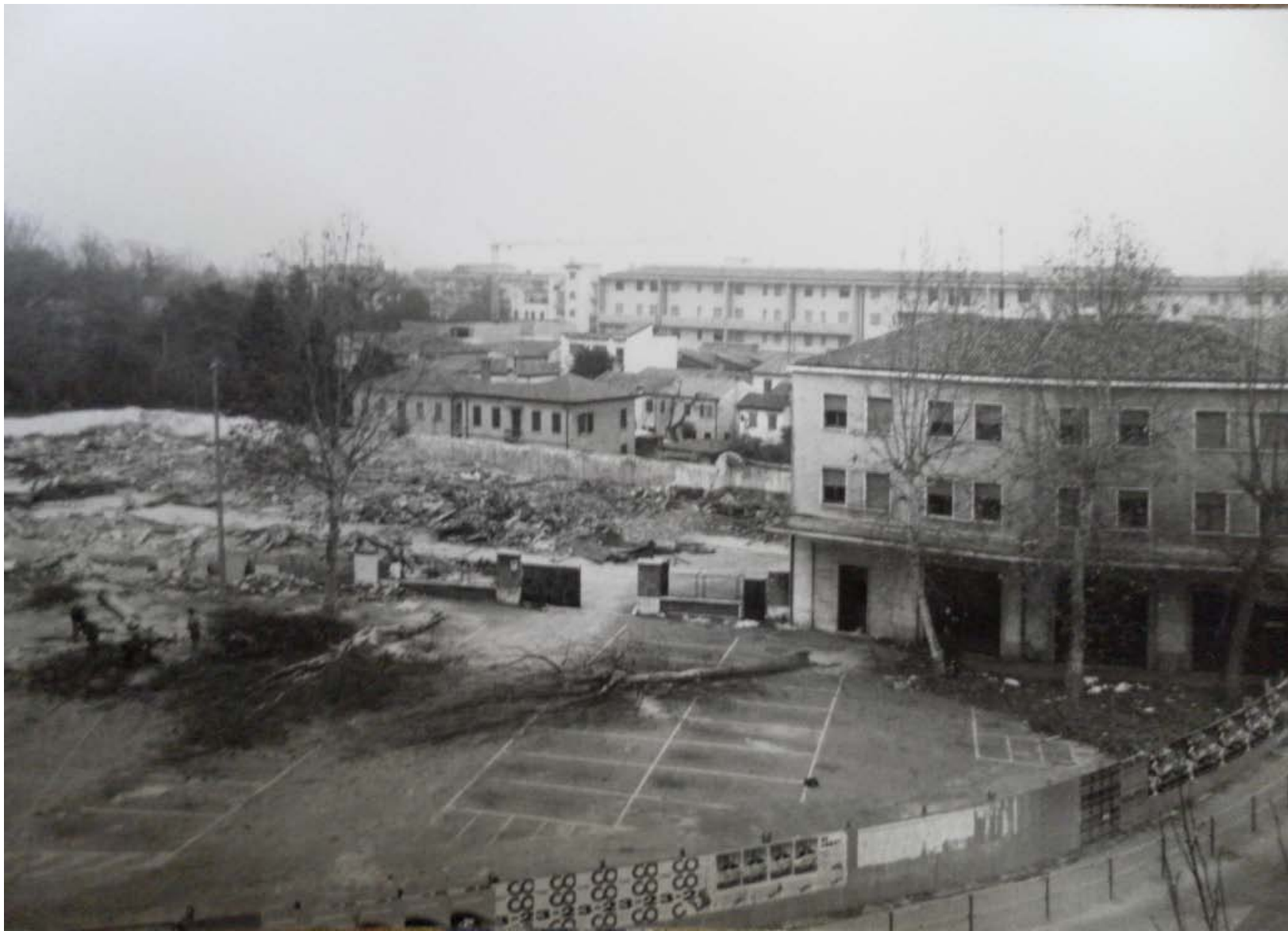
Archivio fotografico club 54 San Donà di Piave piazza 4 Novembre demolizione del Consorzio Agrario e far posto al nuovo complesso EUROPA anno1994
