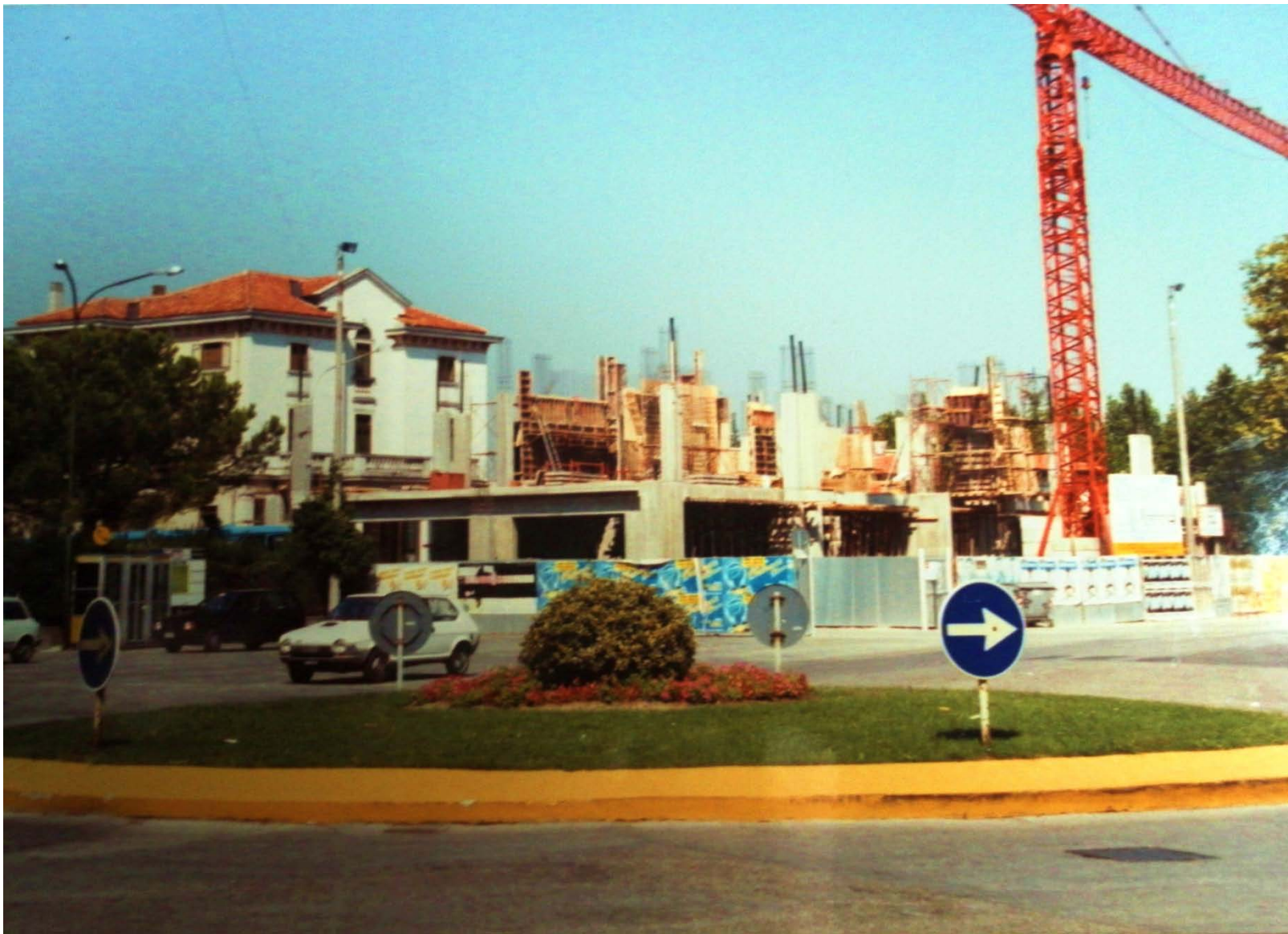
Archivio fotografico club 54 San Donà di Piave piazza 4 Novembre 1987 inizio lavori per la costruzione della nuova autostazione dell'ATVO
