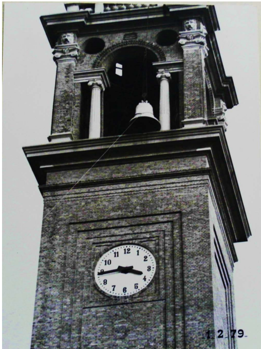
Archivio fotografico club 54 San Donà di Piave la campana ha raggiunto la cella campanaria per essere posizionata sulla sua sede.
