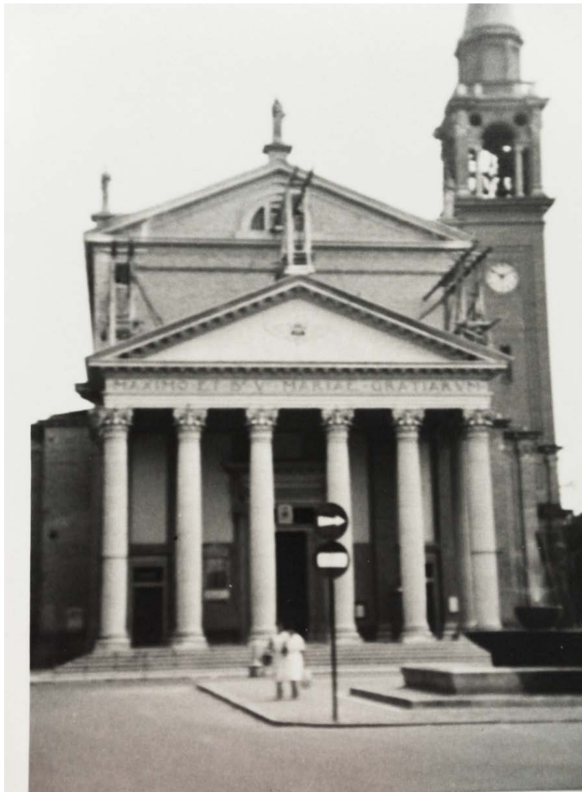
Archivio fotografico club 54 San Donà di Piave piazza Trevisan impalcature sopra il timpano per collocarvi le nuove statue mancanti anno 1958
