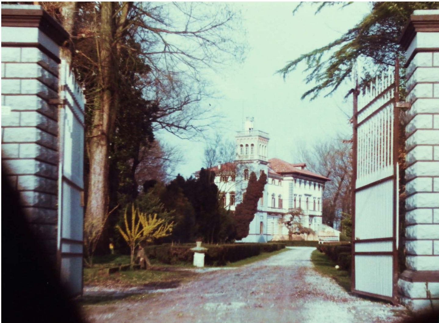
Archivio fotografico club 54 Villa Ancillotto restaurata esternamente dagli Orfei, anno 1983
