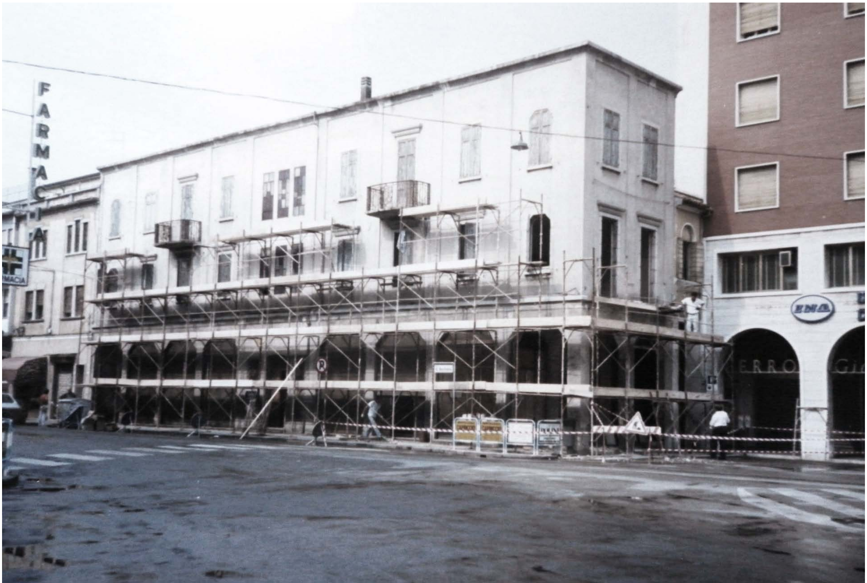
Archivio fotografico club 54 San Donà di Piave piazza Trevisan demolizione del cinema Progresso e far posto al nuovo complesso il Campiello con la galleria Progresso anno 1988.
