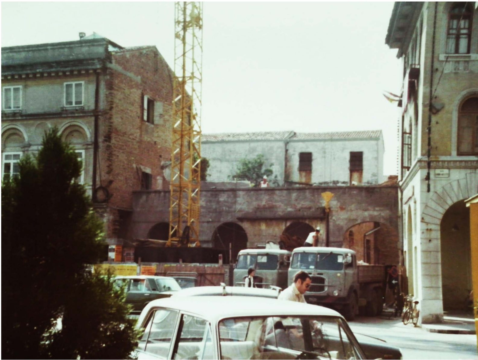
Archivio fotografico club 54 San Donà di Piave Piazza Trevisan inizio lavori sul completamento del palazzo Bressanin anno1975
