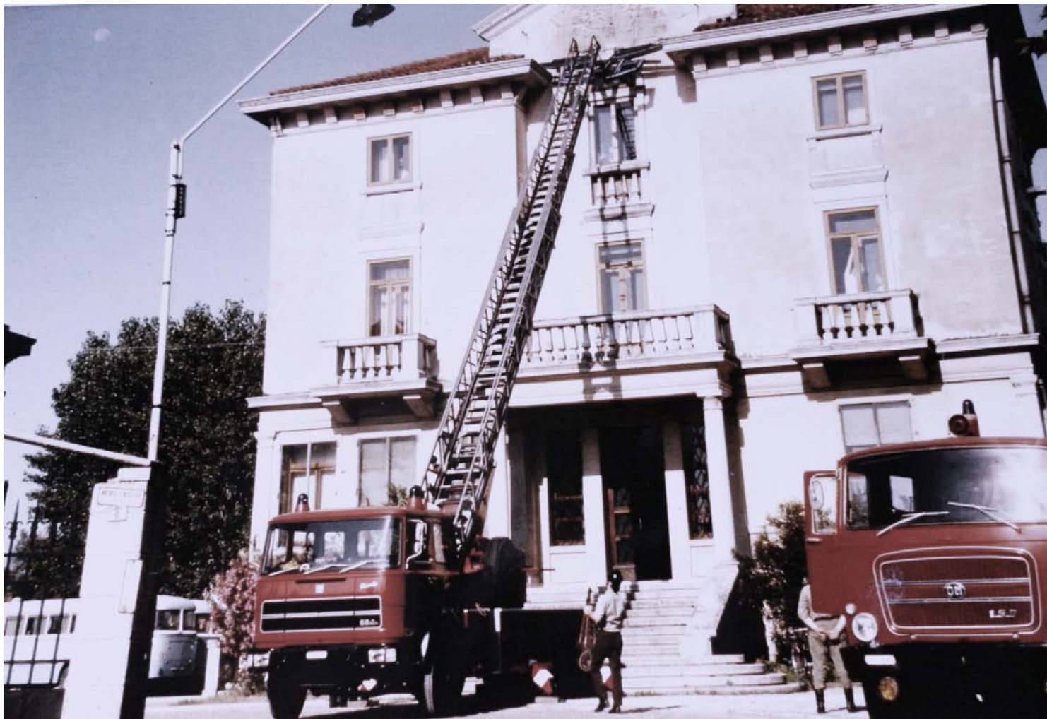
Archivio fotografico club 54 dismissione della villa per far posto alla nova autostazione,i pompieri rimuovono l'insegna della FAP anno 1985
