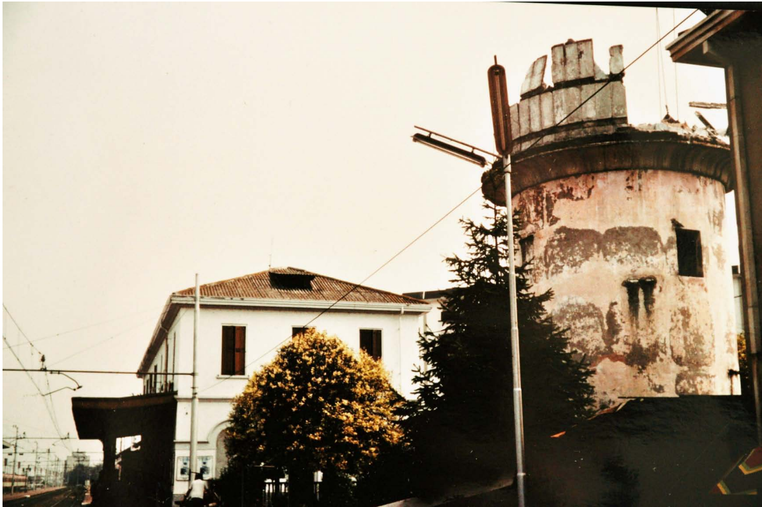
Archivio fotografico club 54 San Donà di Piave stazione ferroviaria demolizione del serbatoio d'acqua anno1983
