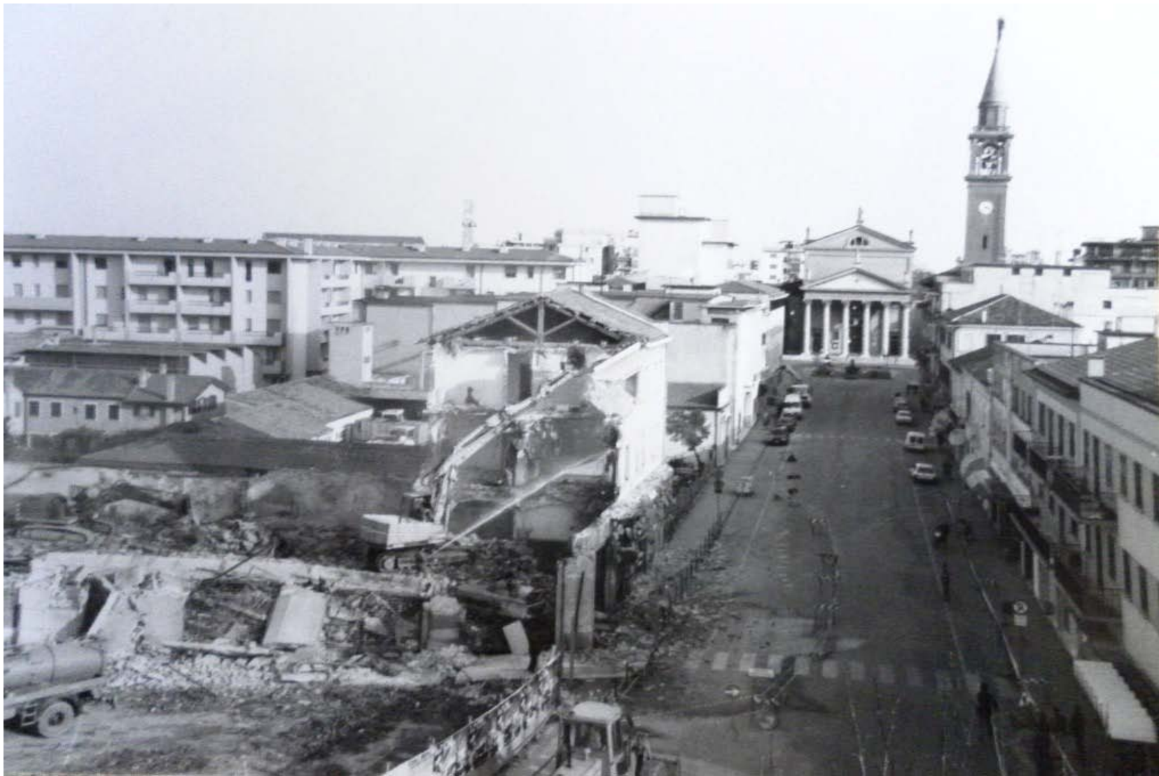
Archivio fotografico club 54 San Donà di Piave piazza 4 Novembre, quasi completata la demolizione del Consorzio Agrario anno1994
