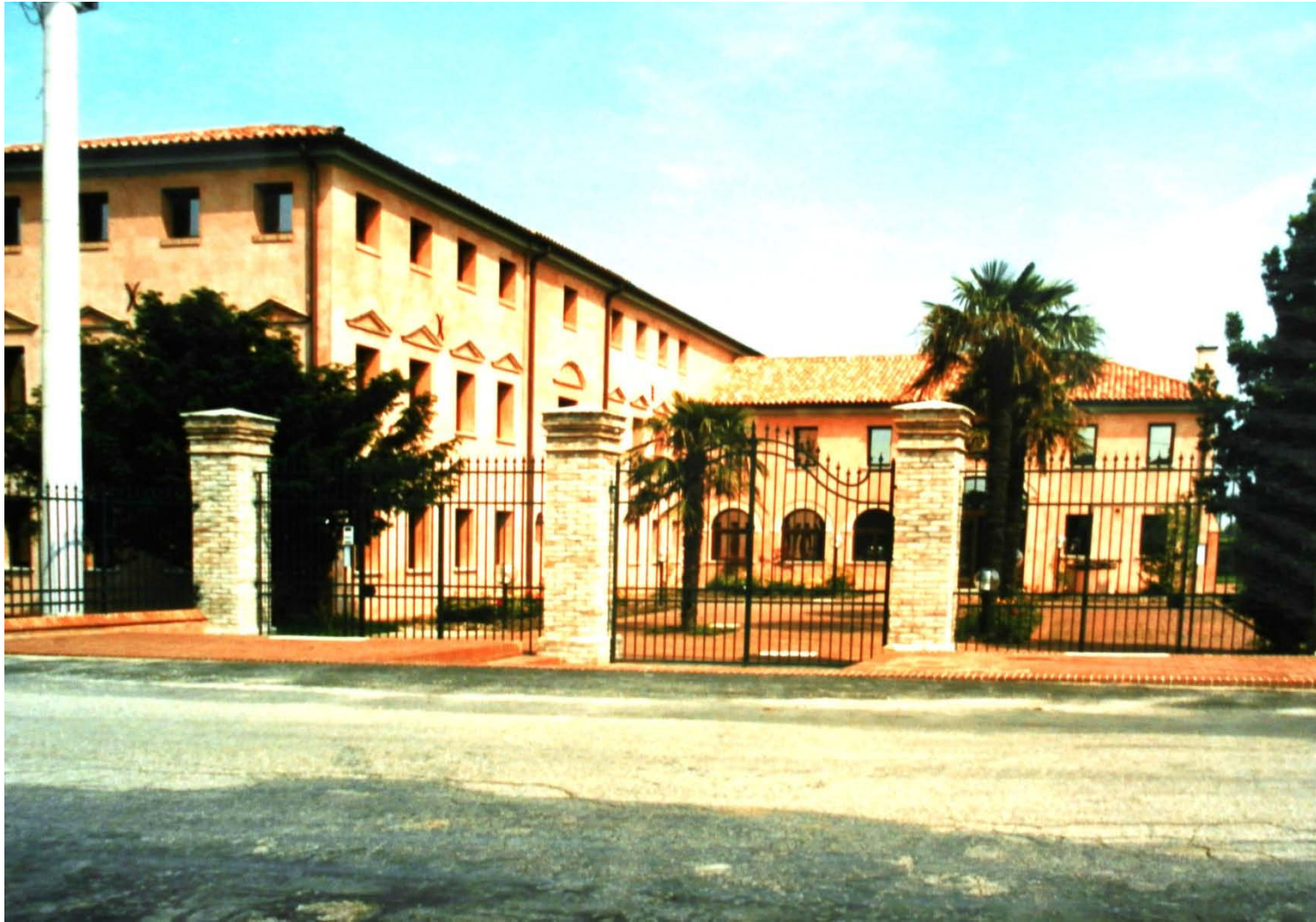
Archivio fotografico club 54 San Donà di Piave la Casa delle Statue dopo il restauro anno 1983
