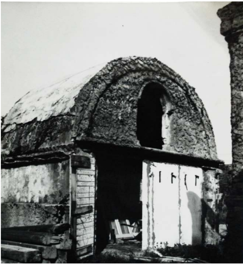
Archivio fotografico club 54 costruzione in pietra povera con volta a botte e le colonne in stile dorico
