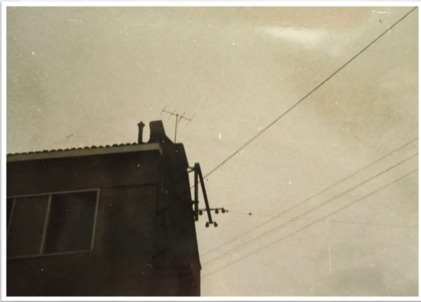
San Donà di Piave il tetto del consorzio agrario di via Ancillotto particolare del sostegno metallico della linea elettrica completamente piegato dal vento.
