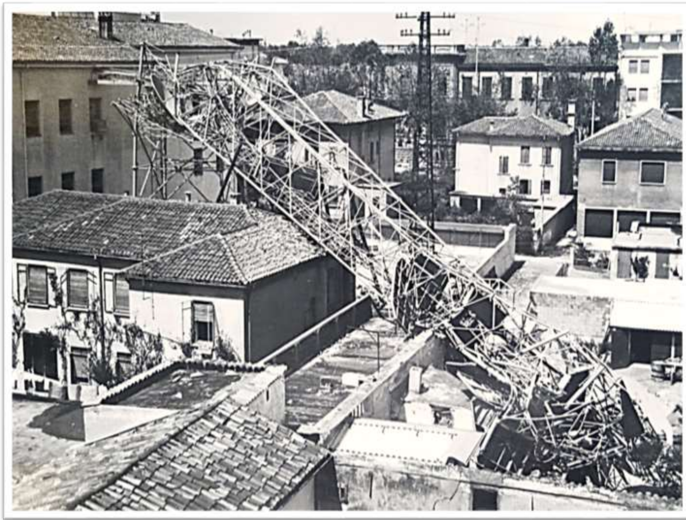
Archivio fotografico club 54 San Donà di Piave l'antenna dei telefoni dello stato abbattuta dalla furia del vento caduta sui tetti sottostanti.
