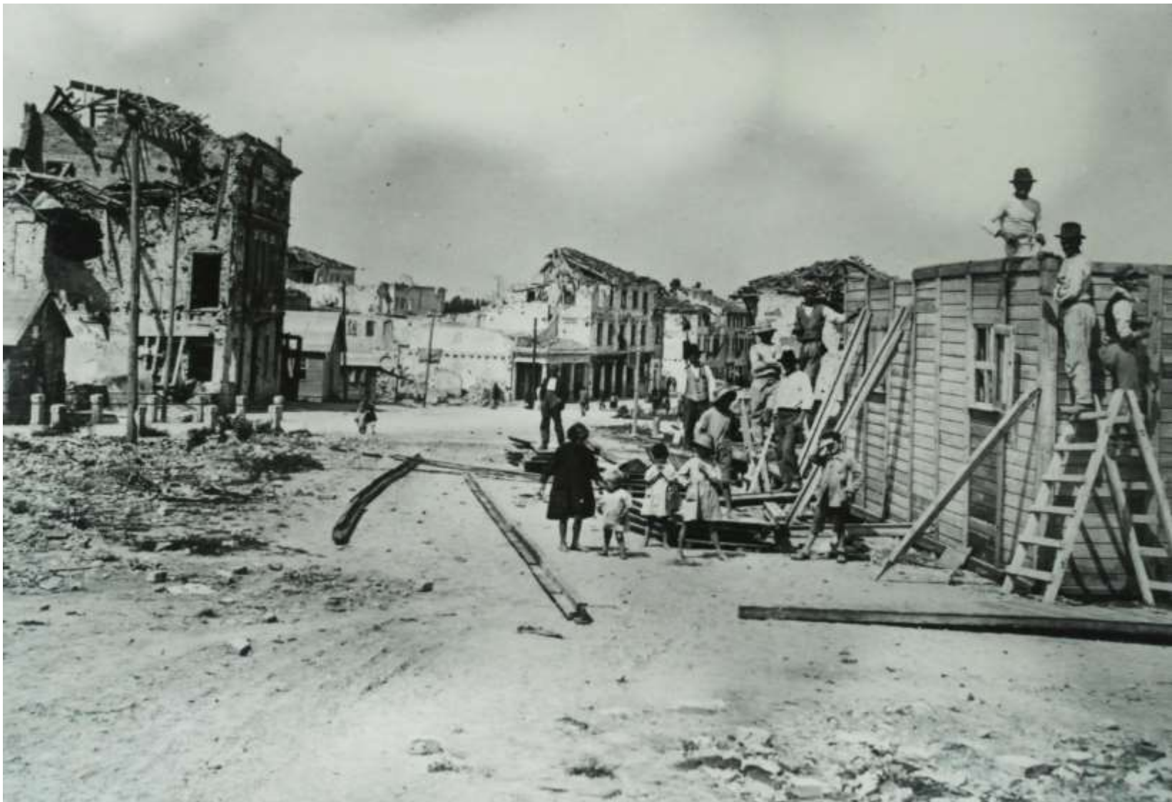
Archivio fotografico club 54 San Donà di Piave baracca in costruzione a metà salita che porta al ponte sul Piave anno 1919
