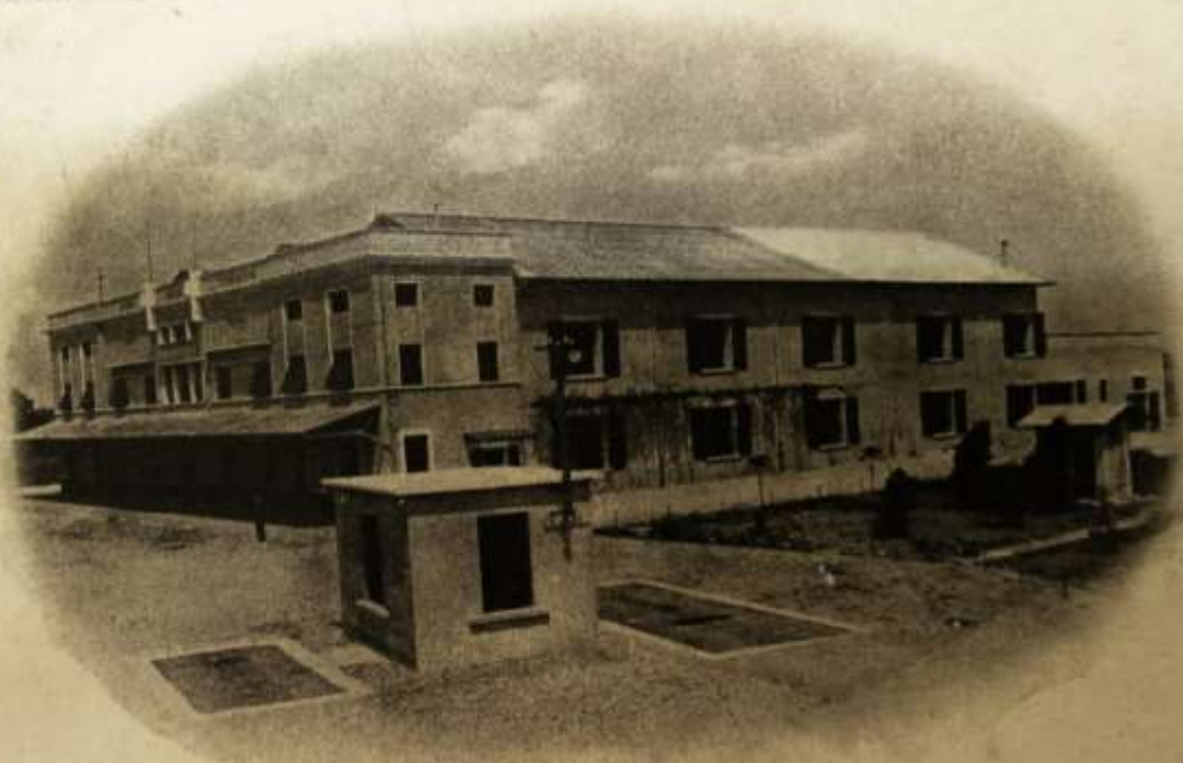
Stabilimento Vinicolo Sociale - Capacità hl. 45000
