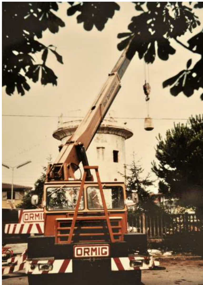
Archivio fotografico club 54 San Donà di Piave stazione ferroviaria demolizione della cisterna d'acqua che serviva a rifornire le locomotive a vapore anno 1983
