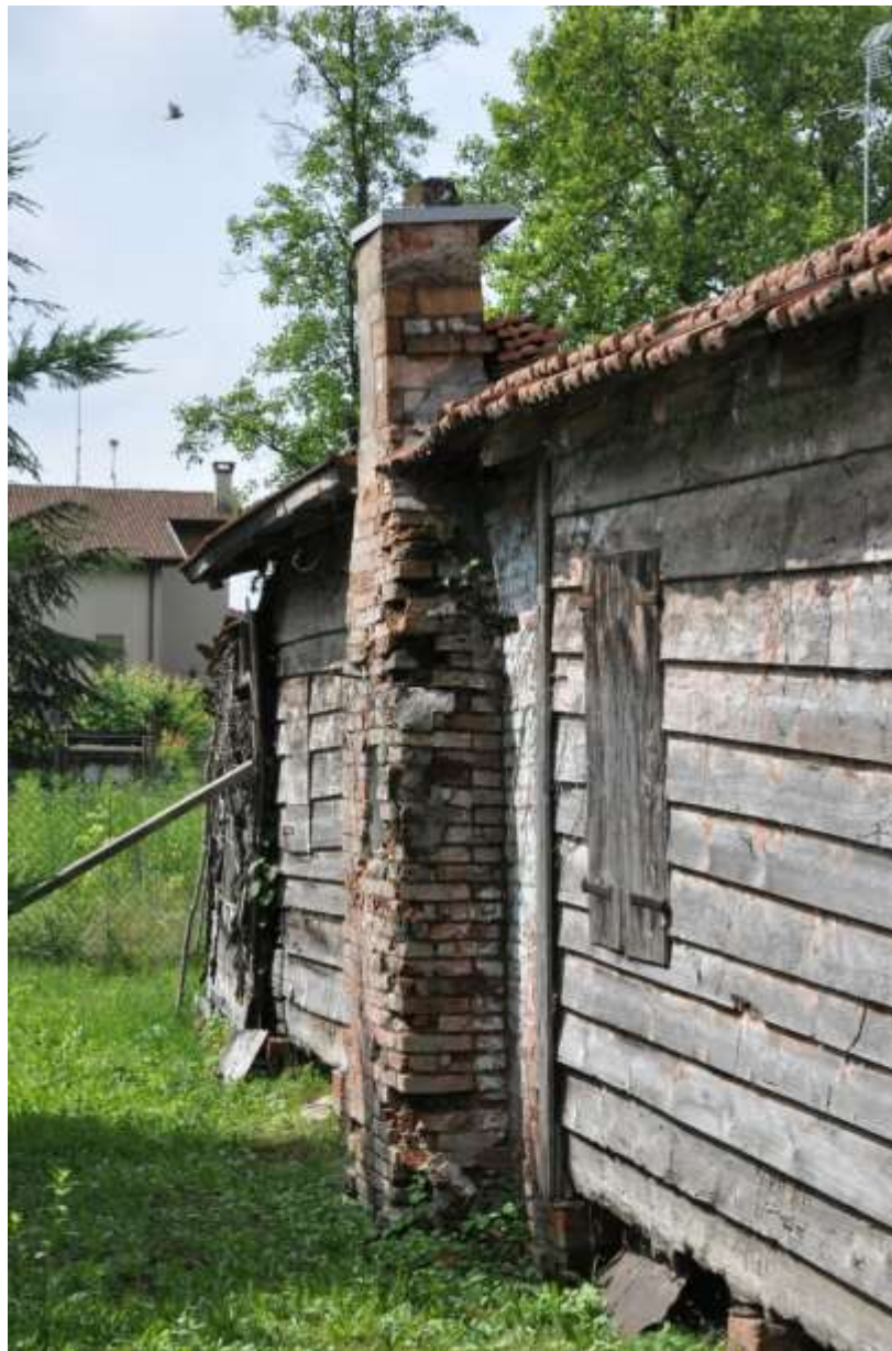
Archivio Fotografico club 54 San Donà di Piave particolare del Fogher in muratura
