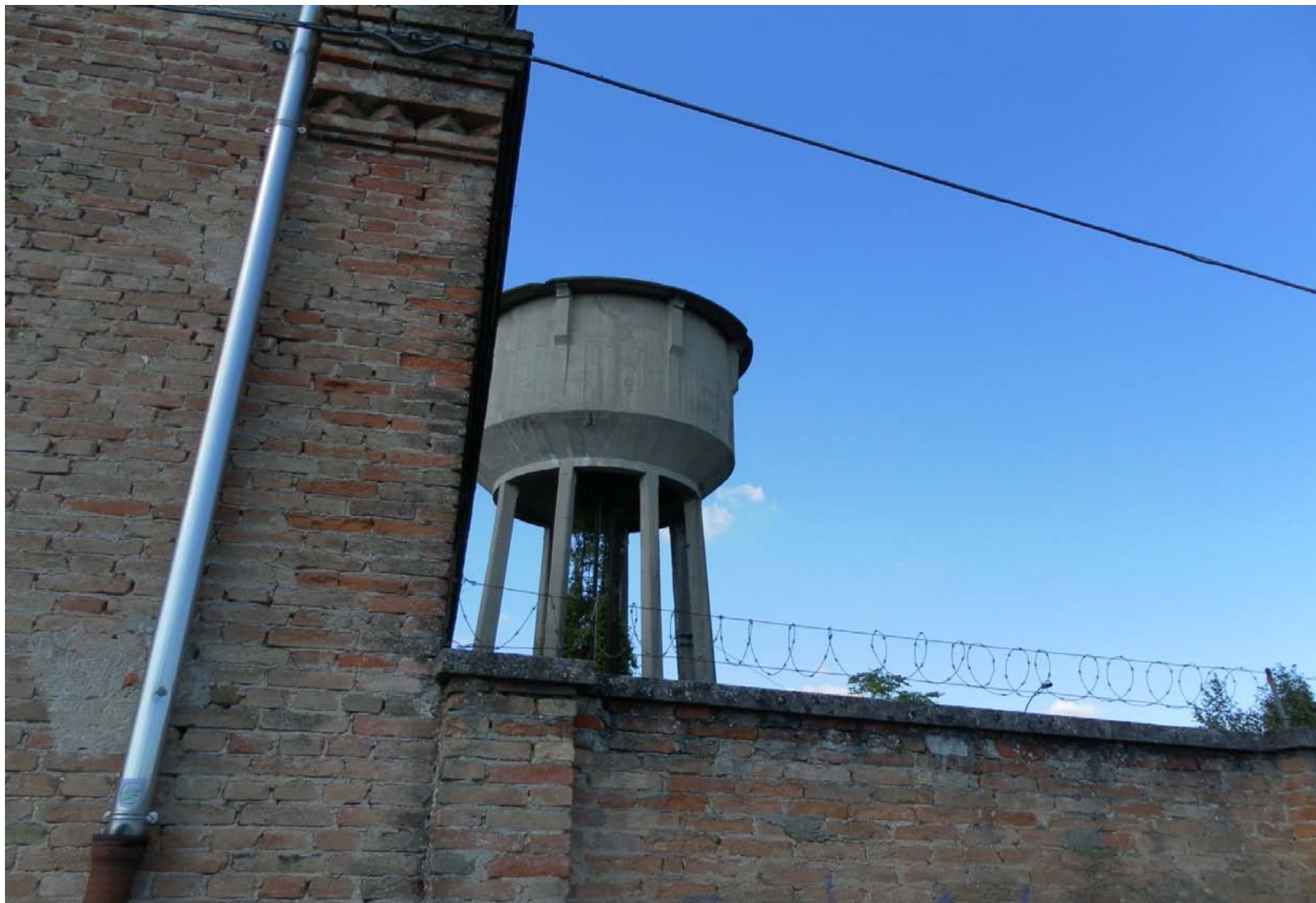
Archivio fotografico del club 54 la torre serbatoio d'acqua in cemento
