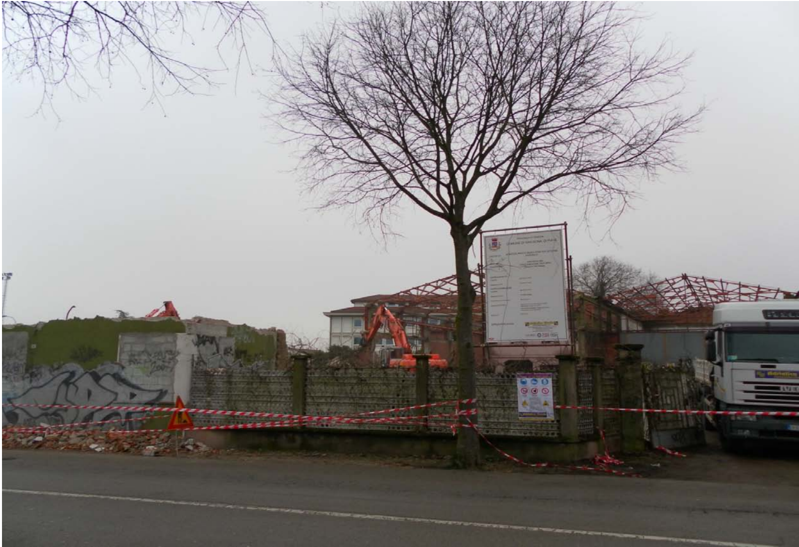
Archivio fotografico club 54 inizio dei lavori di demolizione dell'abitazione e dei capannoni dell'area Barosco da via Pralungo
