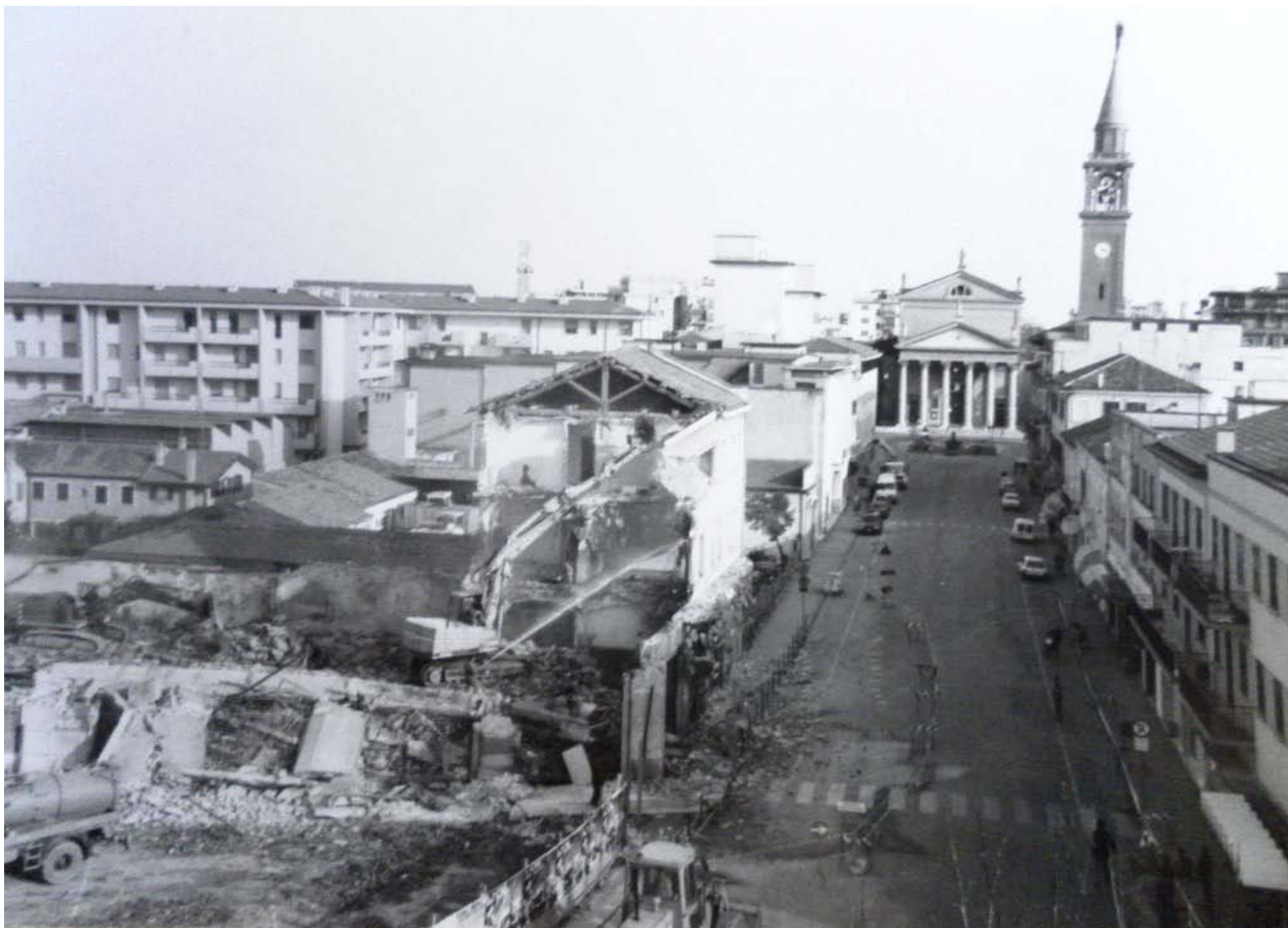
Archivio Fotografico club 54 demolizione del Consorzio Agrario di piazza 4 Novembre e via Ancillotto
