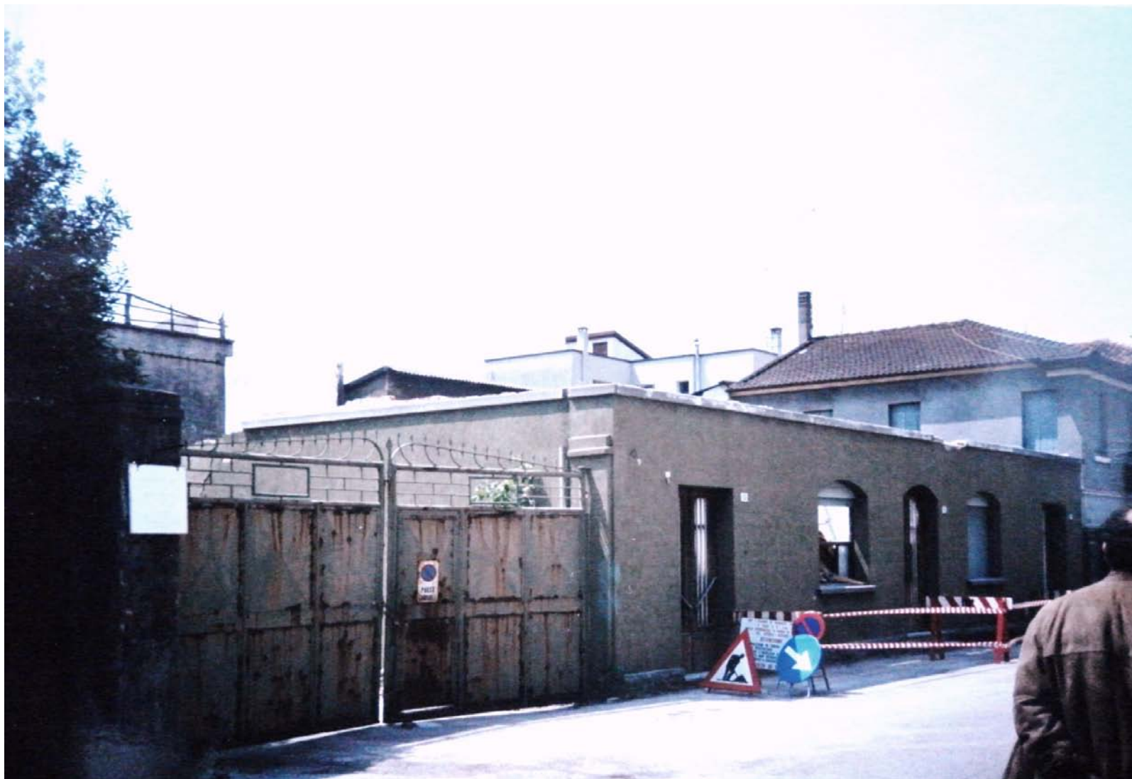
Archivio fotografico club 54 Il portone d'entrata della Kriza in Vicolo Nuovo di San Donà di Piave e quello che rimane della palazzina degli uffici
