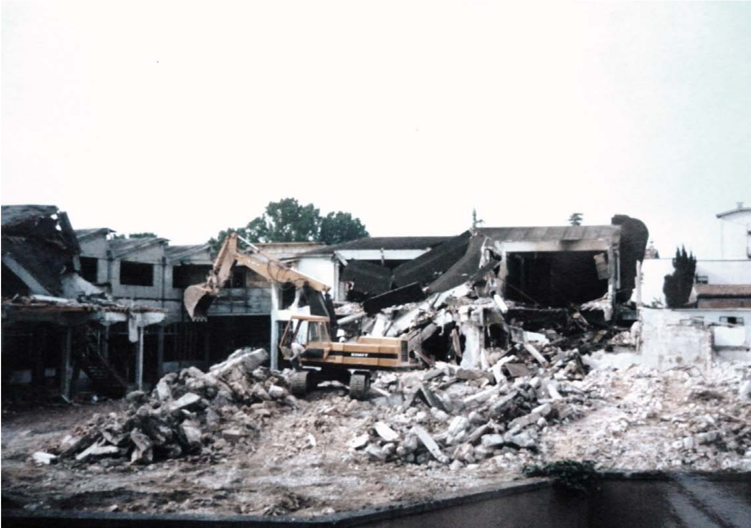
Archivio fotografico club 54 demolizione dei capannoni in cemento armato della Kriza rimasta operativa fino al 1975 che cessò l'attività
