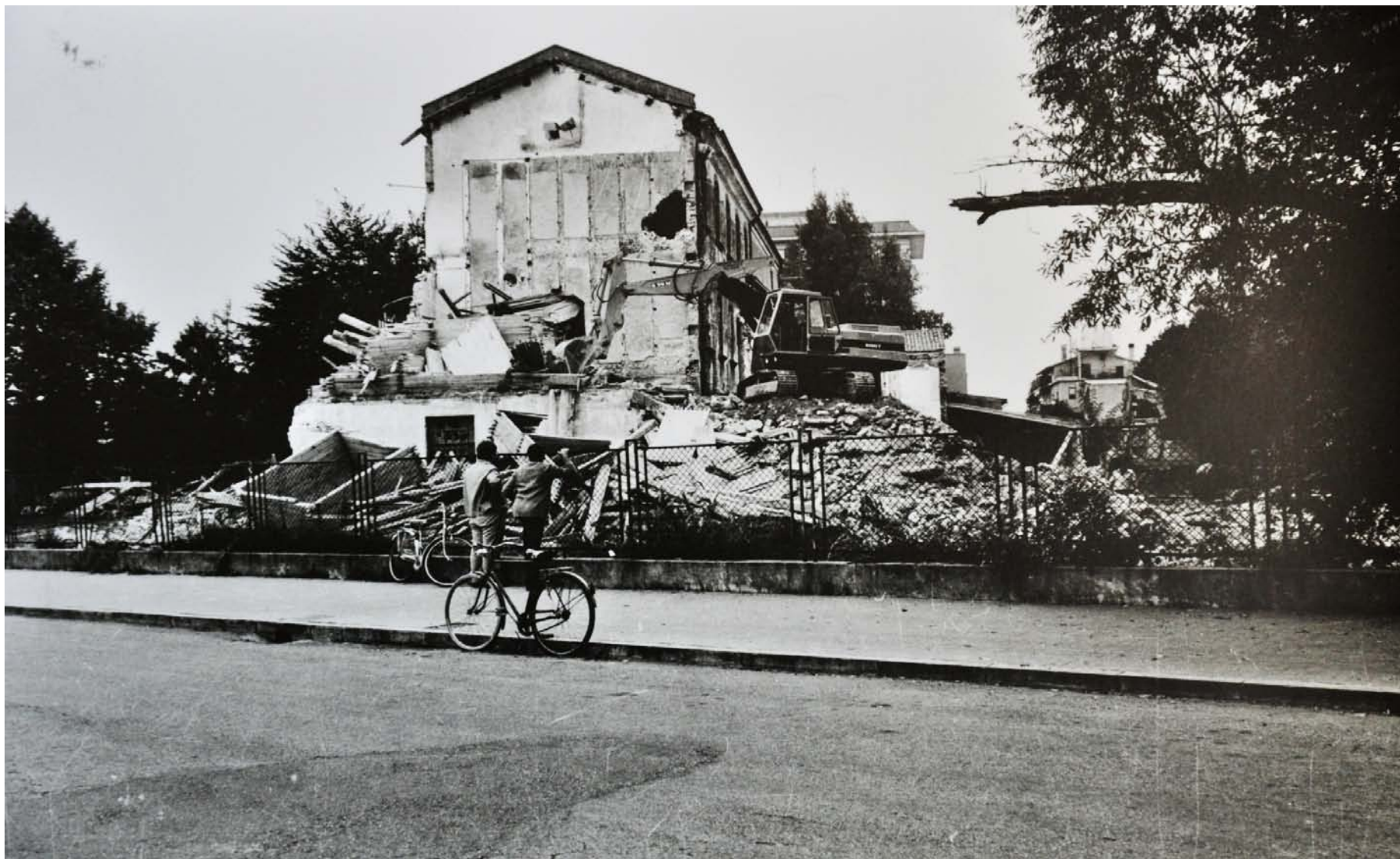
Archivio Fotografico Club 54 continua la demolizione del mulino foto A. Mestre
