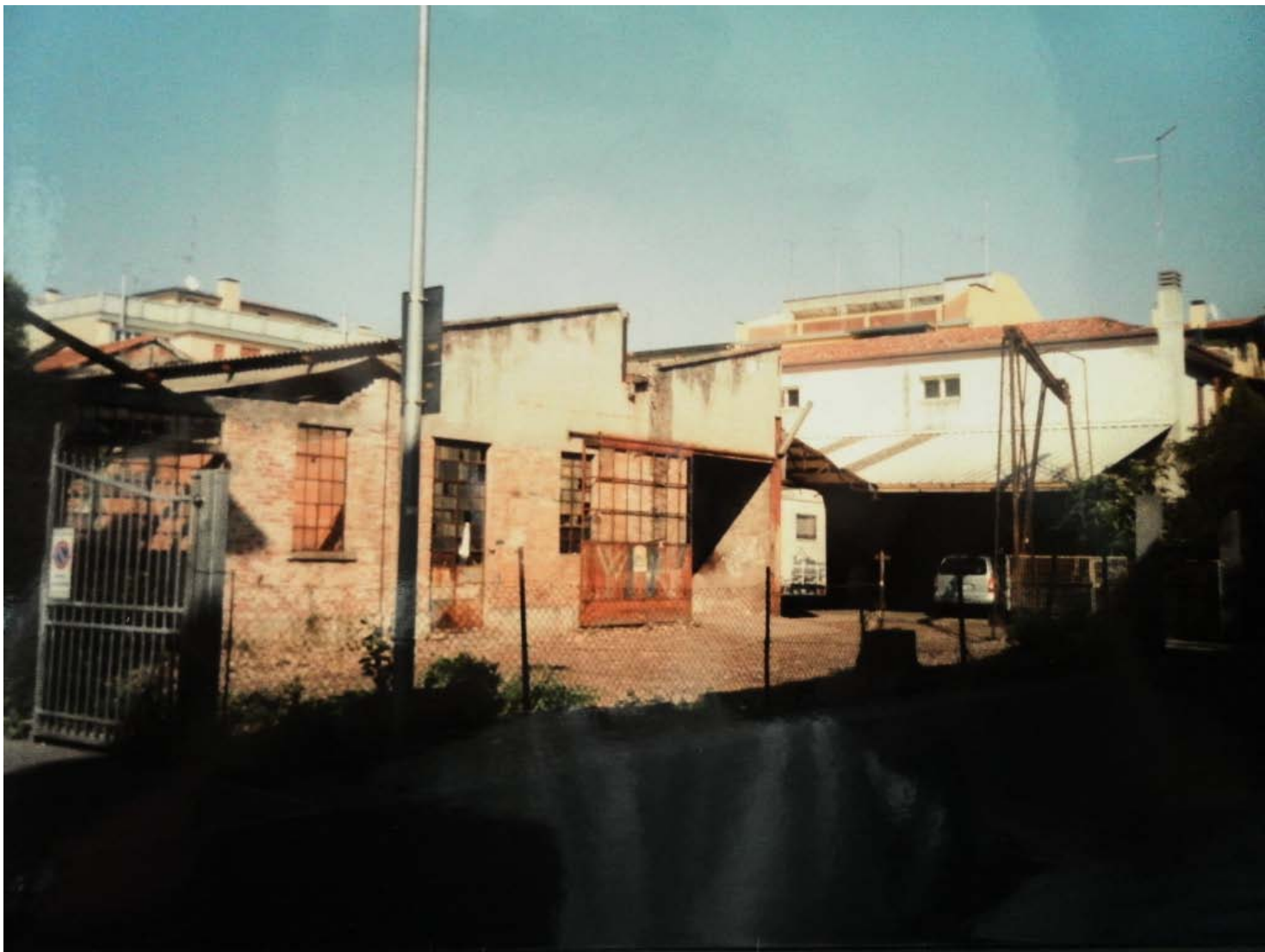
Archivio fotografico Club 54 i capannoni vengono usati come deposito
