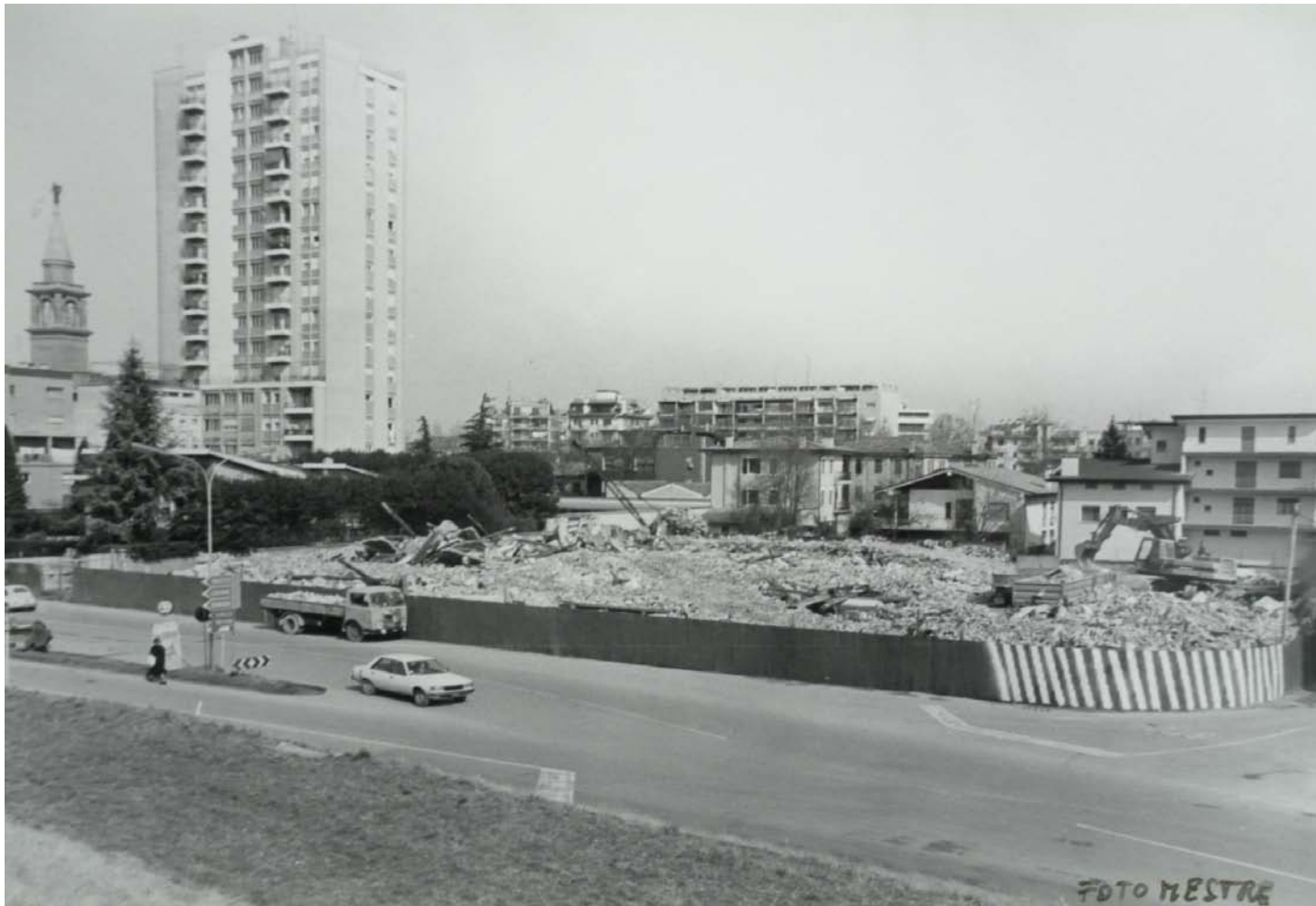
Archivio fotografico club 54 la demolizione della cantina Murer è ultimata
