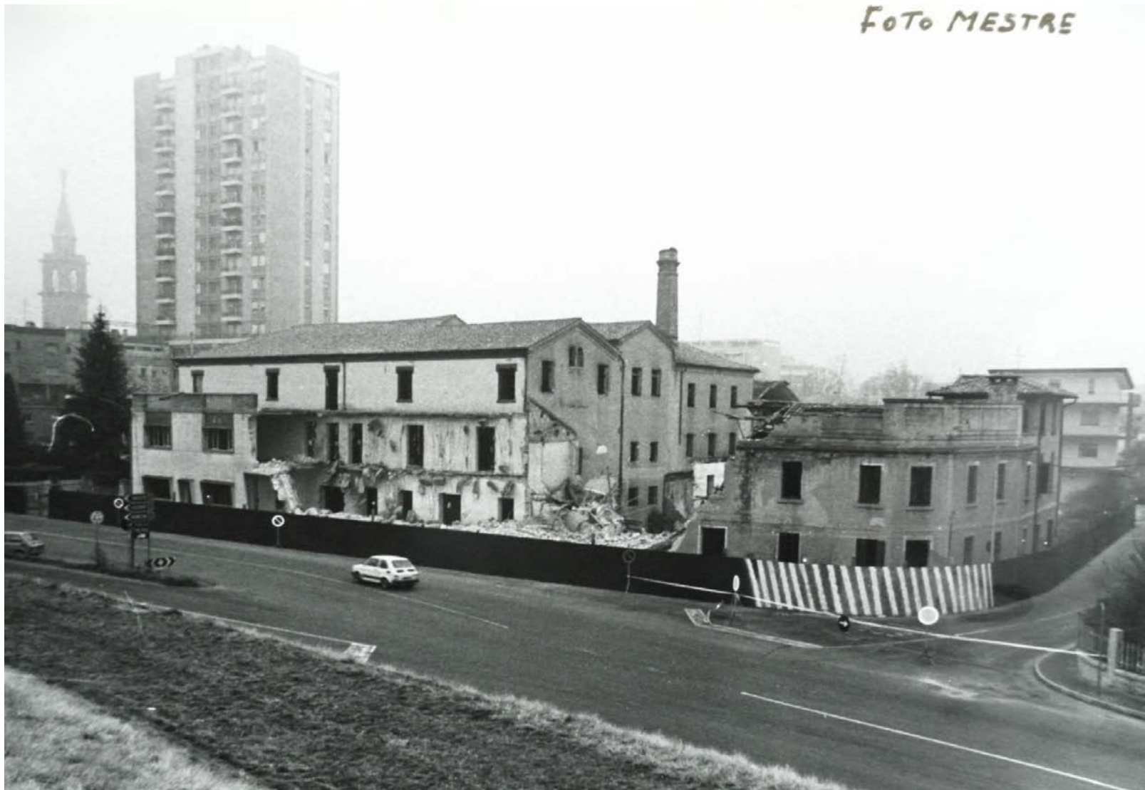
Archivio fotografico club 54 Inizio demolizione della cantina Murera
