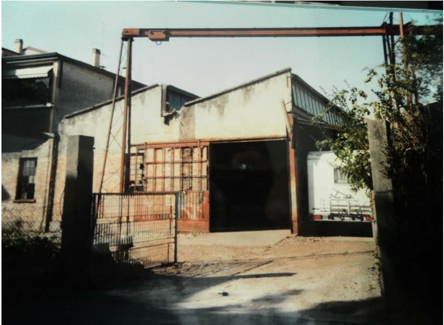
Archivio fotografico club 54 questi capannoni verranno abbattuti per far posto ad un complesso di pregio
