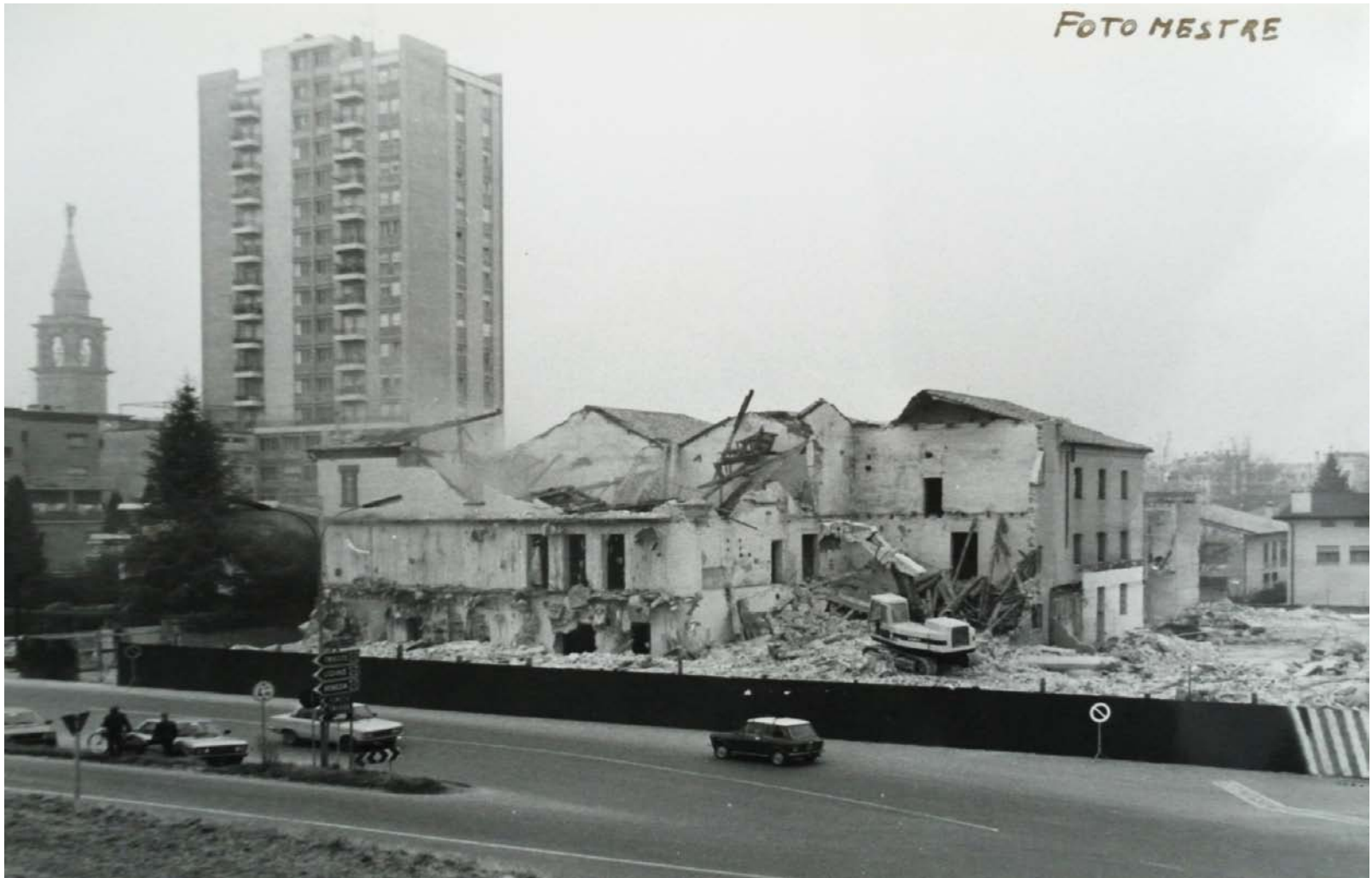
Archivio fotografico club 54 prosegue la demolizione della cantina Murer
