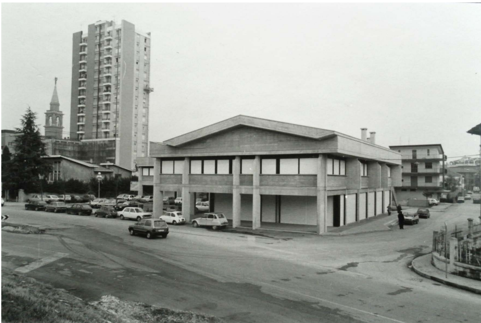
Dalla demolizione delle cantine Murer nasce il nuovo complesso direzionale in via Cesare Battisti a San Donà Di Piave
