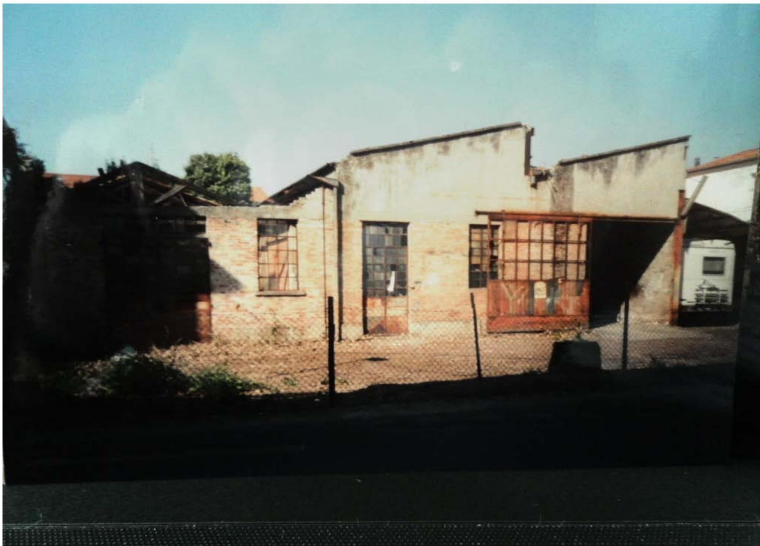
Archivio fotografico Club 54 i capannoni vuoti e abbandonati
