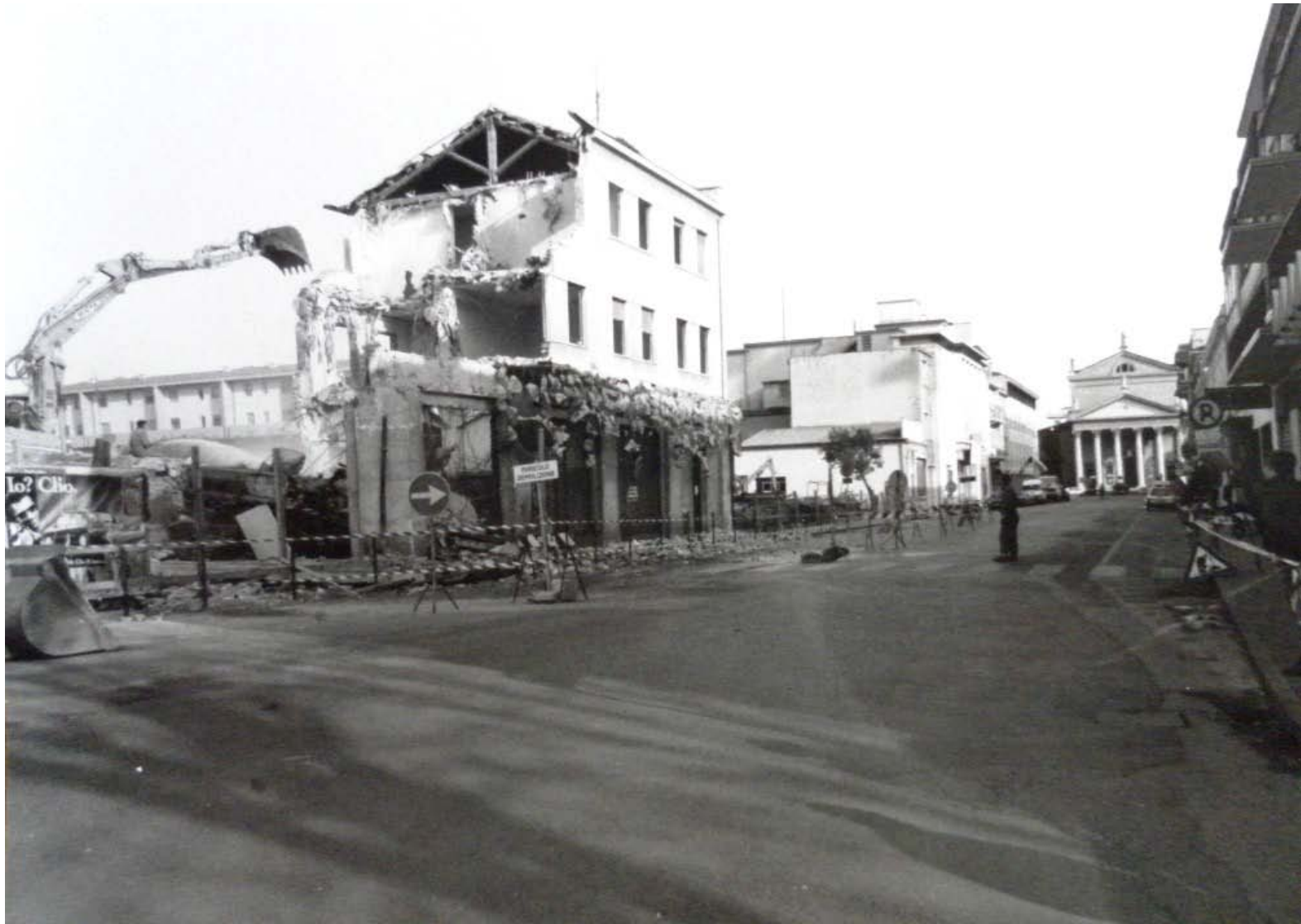
Archivio fotografico club 54 continua la demolizione del consorzio agrario
