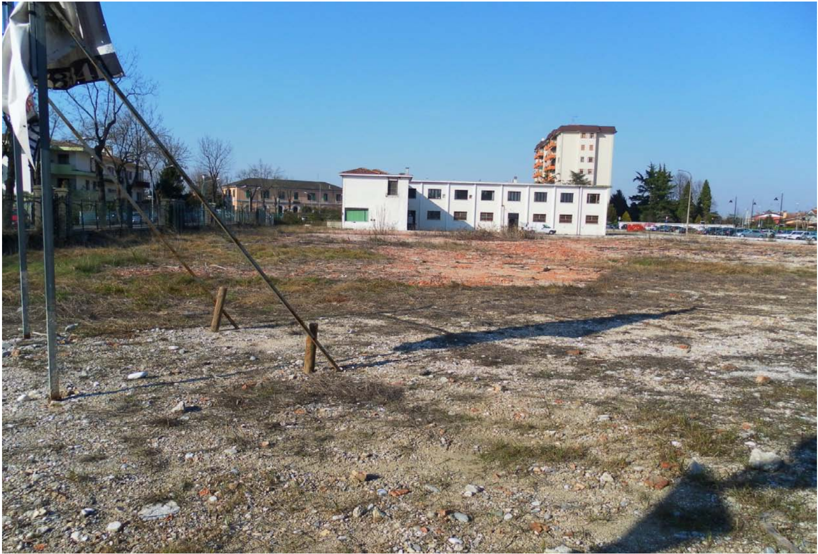
Archivio fotografico club 54 l'unico immobile rimasto, perchè di recente costruzione all'interno dell'area ENEL
