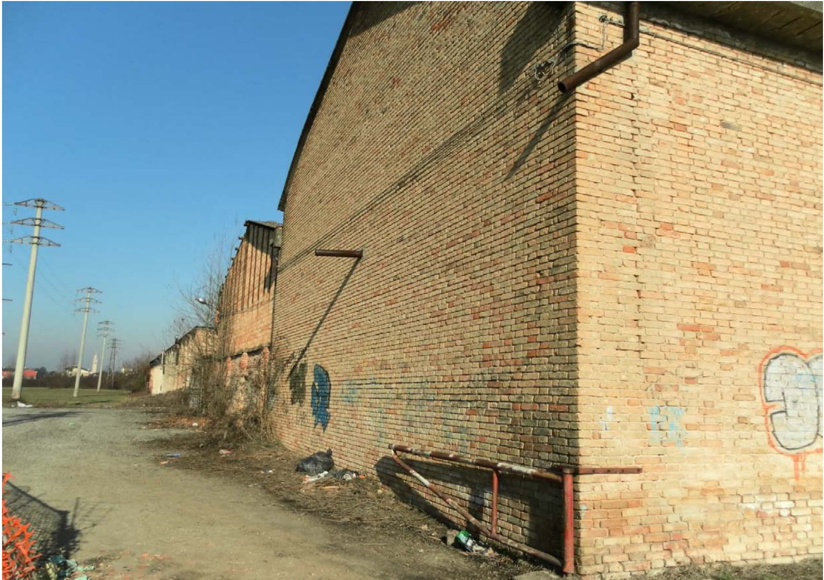
Archivio fotografico del club 54 I capannoni e la mura perimetrale lato sud
