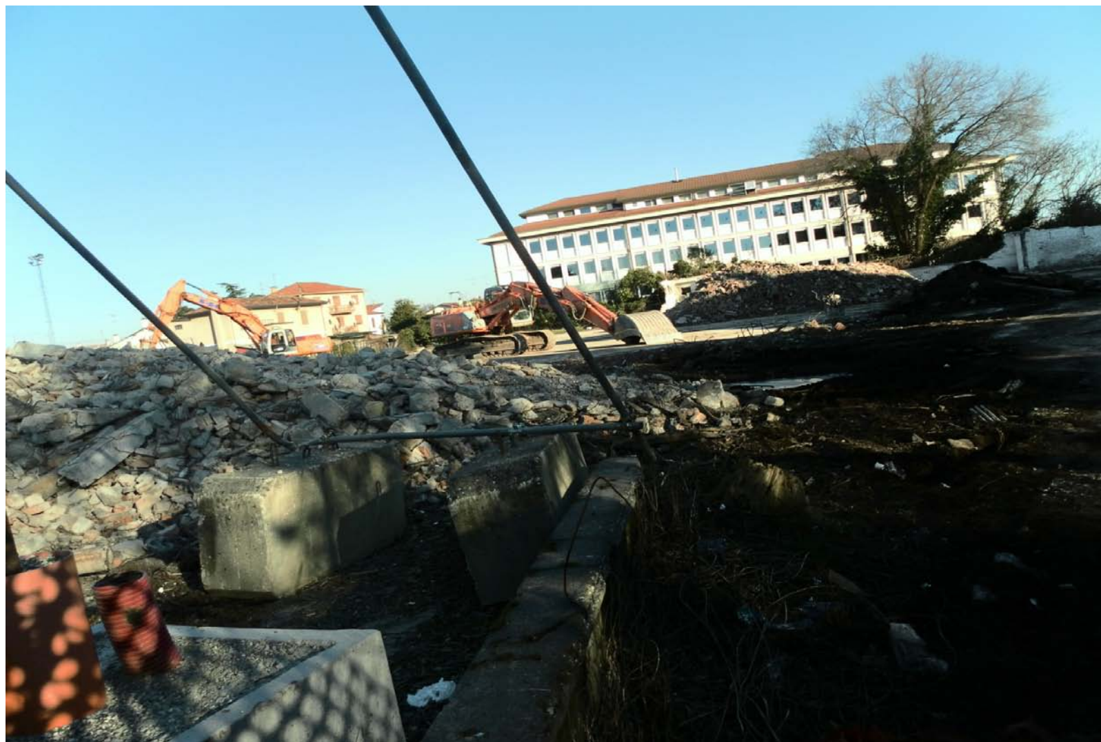
Archivio fotografico club 54 l'area Barosco completamente demolita, l'area verrà riqualificata con un nuovo complesso residenziale commerciale
