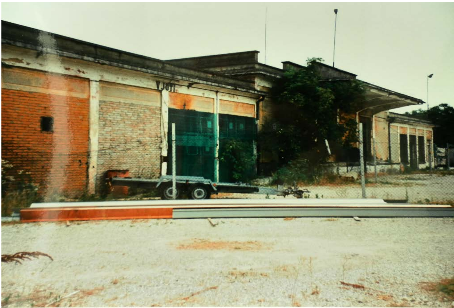
Archivio fotografico club 54 all' interno del deposito abbandonato.
