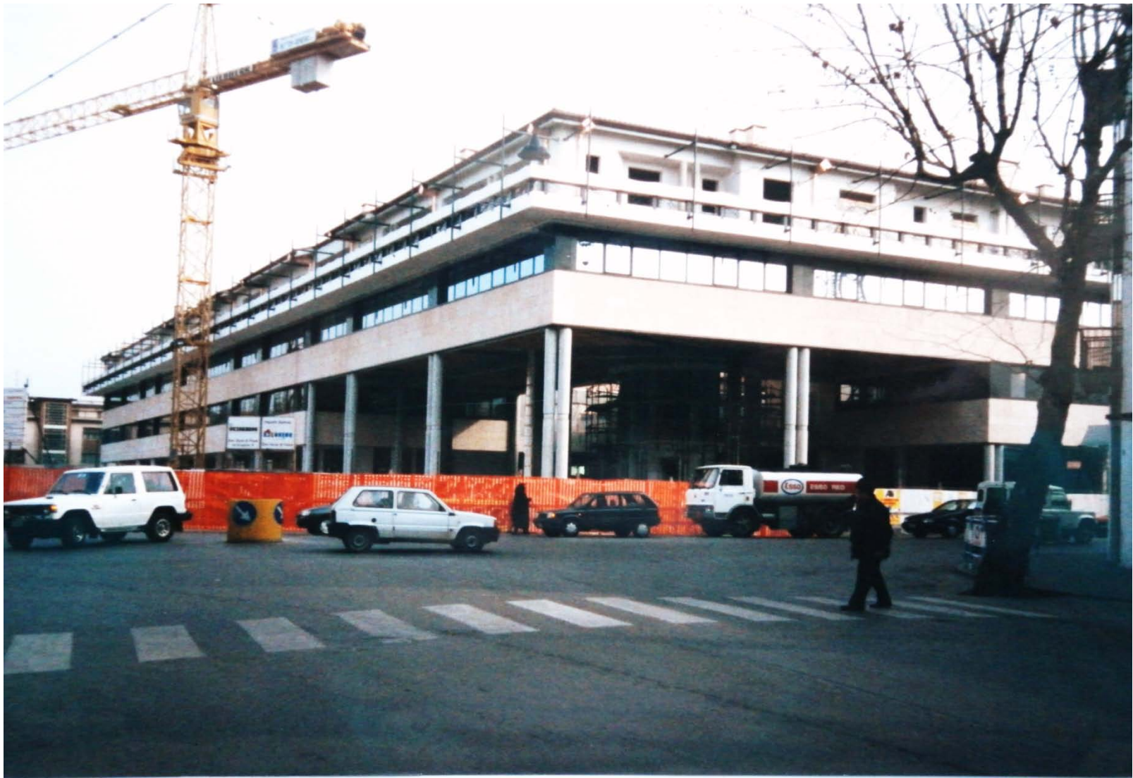
Archivio fotografico club 54 il complesso Europa in via di ultimazione foto di A. Mestre
