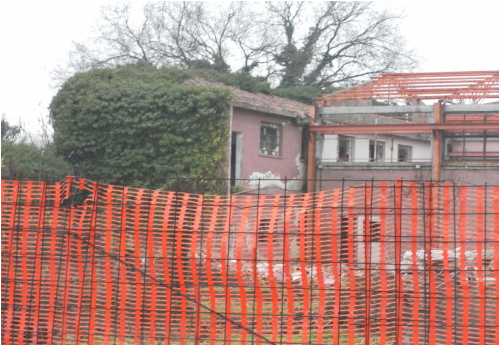
Archivio fotografico club 54 Demolizioni lato via Verdi
