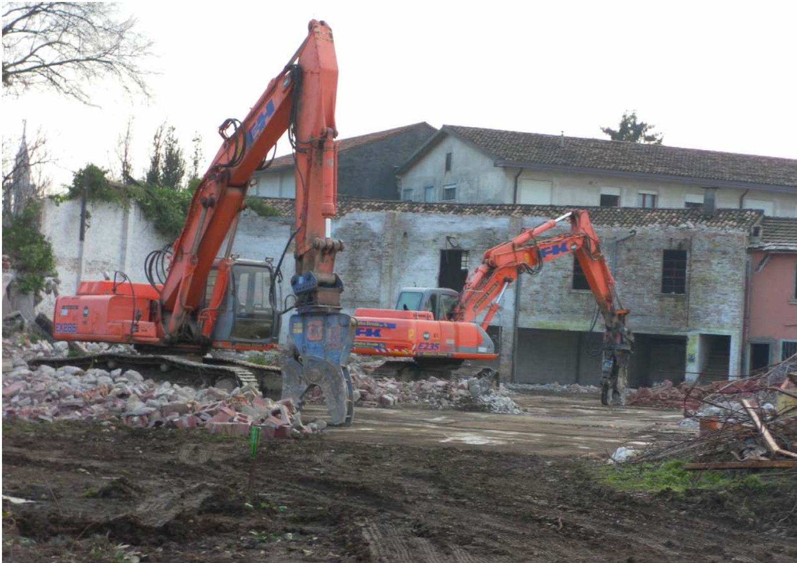
Archivio fotografico club 54 l'area Barosco quasi ultimata la demolizione
