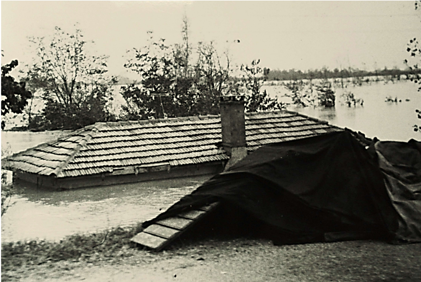
Archivio fotografico club 54 San Donà di Piave la piena completamente sommerso la casa Schiavon e le masserizie accatastate sulla strada sopra l'argine.
